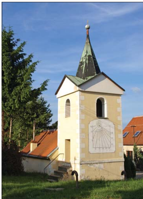
Zděná patrová zvonice ve Svatobořicích se slunečními hodinami, 2009. Foto J. Káčer. Fotoarchiv SM UH.
