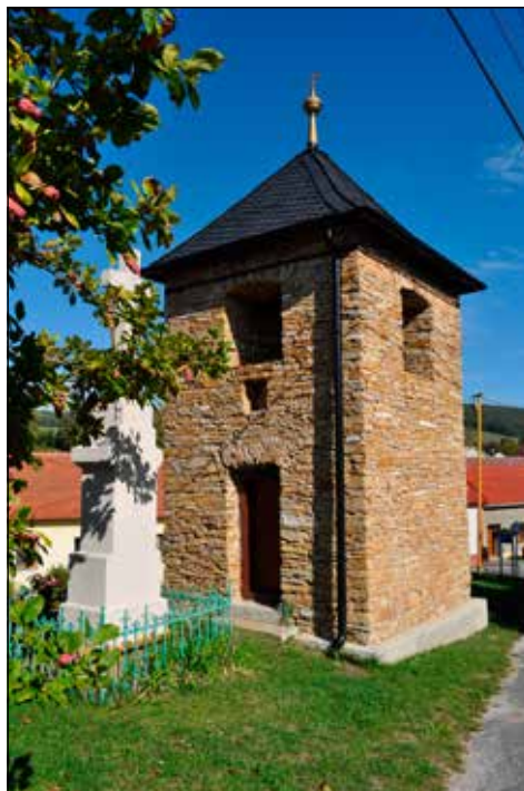
Zvonce zděná z lomového kamene v horní části návsi v Bystřici pod Lopeníkem, 2019. Foto J. Káčer. Fotoarchiv SM UH.
