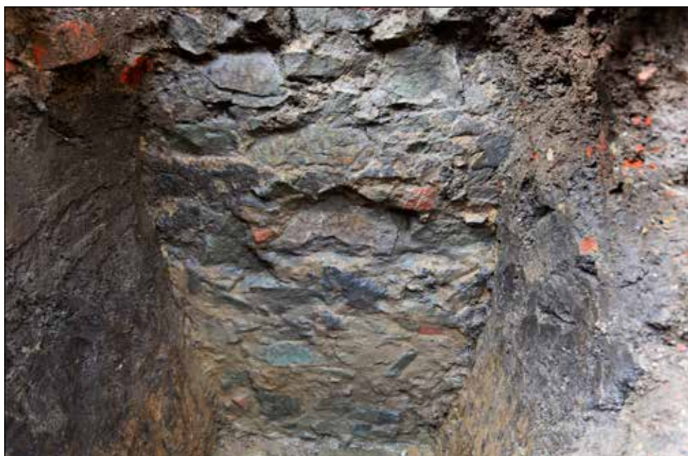
Obr. 10. Pohled na kamenné zdivo odkryté v sondě 1. Foto J. Bartík.
