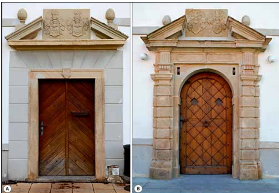
Obr. 8. Vstupní portály do zámku. A – reliéfní deska s aliančním znakem Jakartovských ze Sudic a Soběkurských ze Soběkur v nadpraží vstupu do SV křídla zámku; B – alianční znaky Františka Horeckého a jeho ženy Růženy hr. Serenyi umístěné nad SZ vstupem do zámku.
