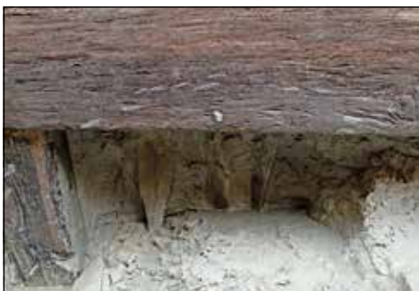
Obr. 11. Foto zachycující v detailu podobu dřevěných konstrukcí, nacházejících se pod kvádrovým zdivem. Foto J. Bartík.
