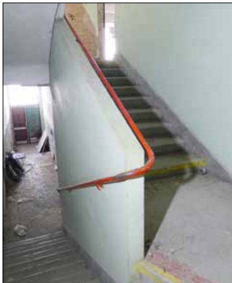
Schodiště, 2018. Foto V. Říhová.
