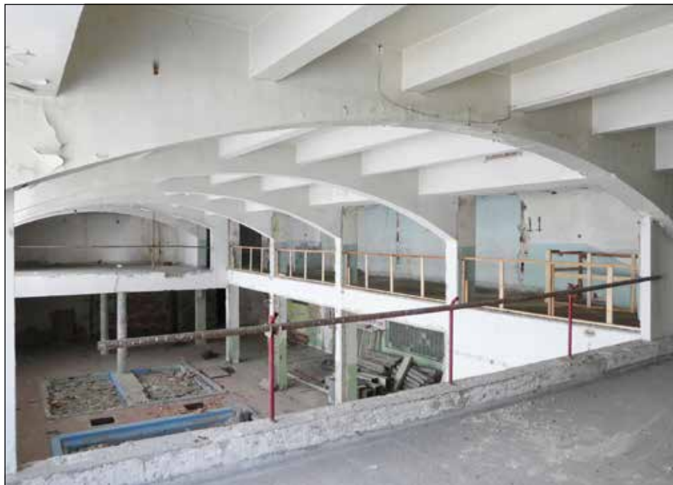
Stropní konstrukce bazénové haly, 2018. Foto V. Říhová.
