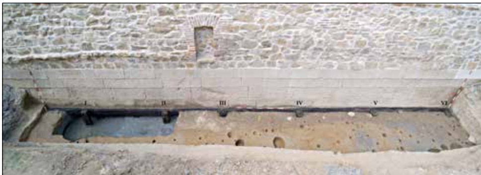
Obr. 3. Pohled na zrekonstruovaný úsek hradby a odkryté dřevěné konstrukce. Foto J. Bartík. Číslování kůlů odpovídá číslům dendrochronologických vzorků v tabulce 1.
