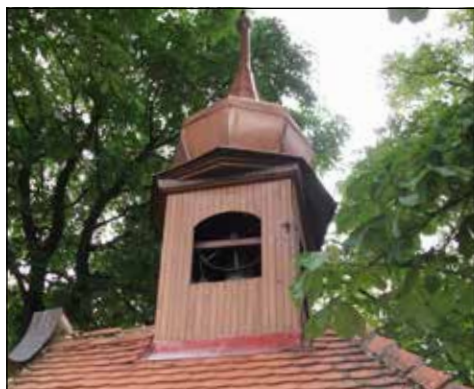
Zvonicový nástavec na kapli Panny Marie Pomocnice v Mistřicích-Javorovci, 2018. Foto J. Káčer. Fotoarchiv SM UH.
