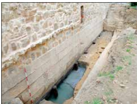
Obr. 4. Detailní pohled na kvádrové zdivo ve spodní části hradby. Foto J. Bartík.
