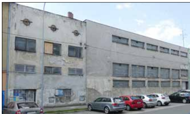
Uliční průčelí městských lázní, 2018. Foto V. Říhová.
