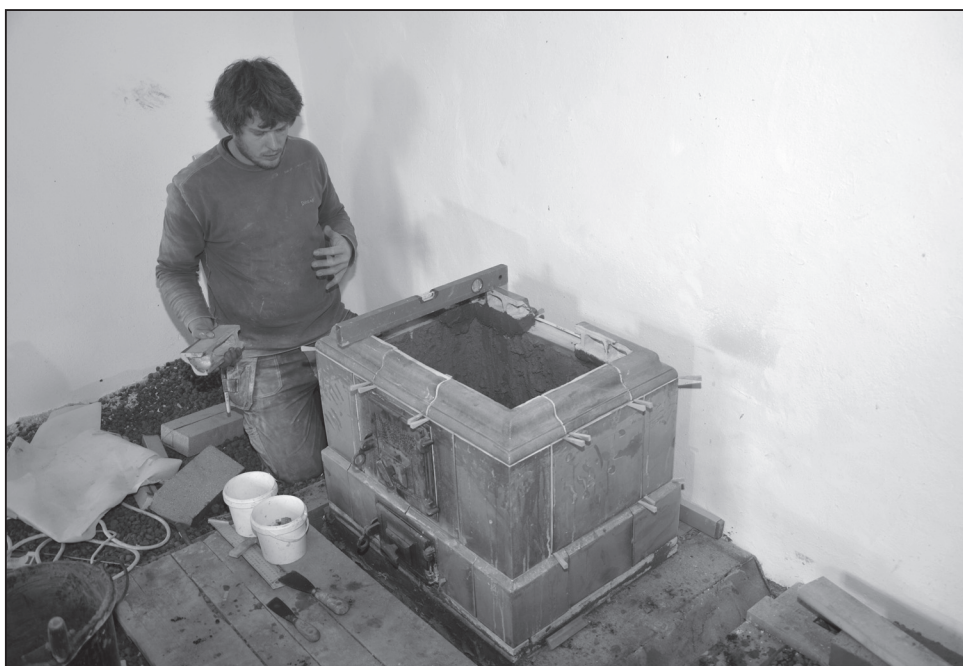
Stavba kachlových kamen kamnářem Vojtěchem Janečkem z Uherského Hradiště-Mařatic v expozičním objektu z Boršic čp. 288, 2015. Foto J. Blahůšek.
