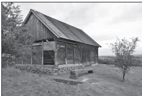
První stavba Muzea v přírodě Rochus – stodola z Břestku po dokončení transferu, 2012. Foto J. Blahůšek.
