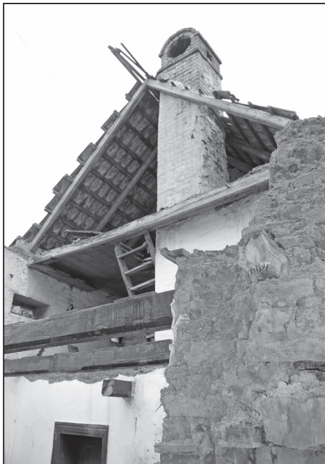
Komínové těleso s udírnou při demolici ve Veletinách čp. 120, 2013. Foto J. Káčer, fotoarchiv Parku Rochus, o.p.s.
