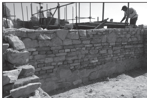
Výstavba kopie objektu z Boršic čp. 288 – zdění stěn z různých materiálů – kámen, nepálené i pálené cihly, 2015. Foto J. Blahůšek.
