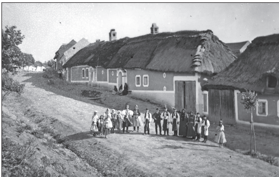
Usedlosti z Mařatic se zdobnými komínovými hlavami, 1892. Foto J. Klvaňa, fotoarchiv Slovákkeho muzea v Uherškém Hradišti.
