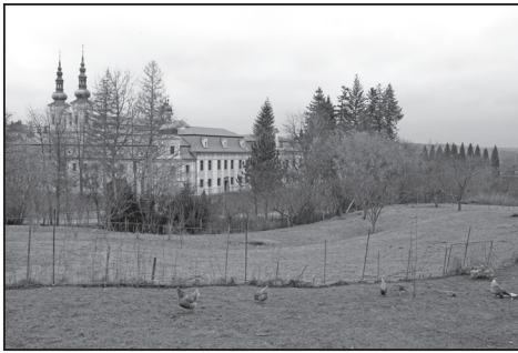
Obr. 3. Pohled od západu na severovýchodní část torza opevnění v poloze „Dolní Hrádek“. V pozadí stavby bývalého cisterciáckého kláštera situovaného na levém břehu říčky Salašky. Patrná je barokně upravená kruhová věž zesilující jihozápadní nároží původního opevnění kláštera, Velehrad (okr. Uherské Hradiště) 2015. Foto Z. Schenk.
