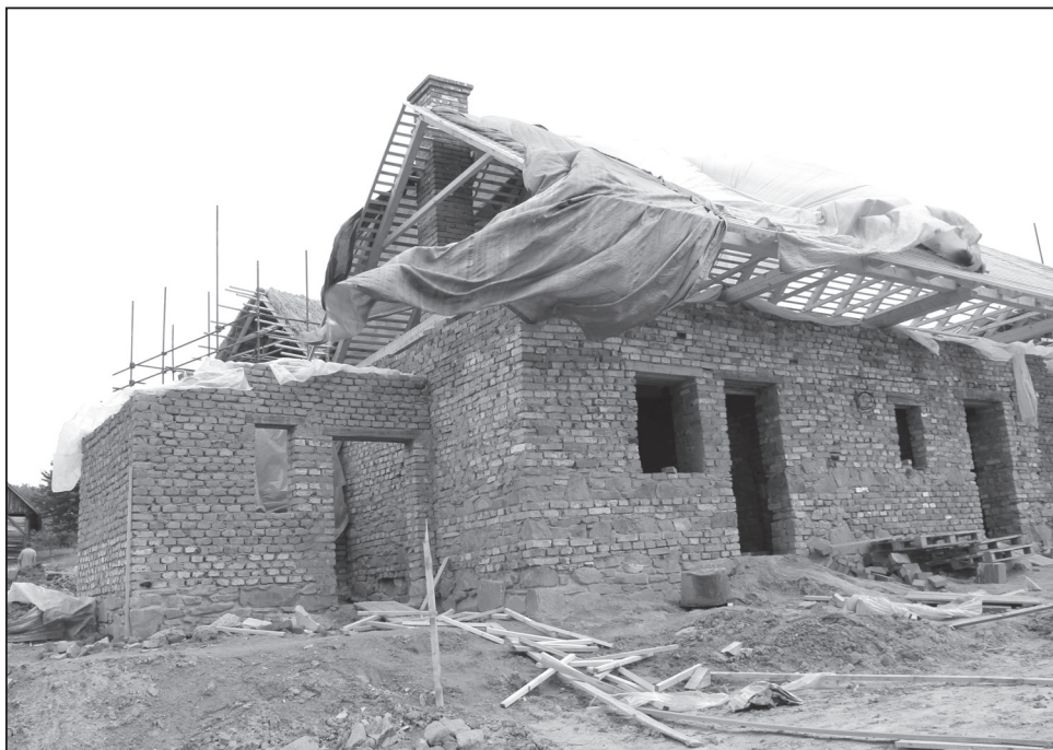
Rozestavené hospodářské křídlo zemědělské usedlosti z Boršic. Foto J. Kácer, fotoarchiv Parku Rochus, o.p.s., 2015.
