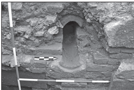
Obr. 4. Detail raně novověké odpadní výpustě vezděné do tělesa původní vrcholně středověké hradby. Foto J. Bartík.
