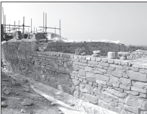
Kombinované zdivo na hliněnou maltu hospodářského křídla usedlosti z Boršic. Foto J. Káčer, fotoarchiv Parku Rochus, o.p.s., 2015.
