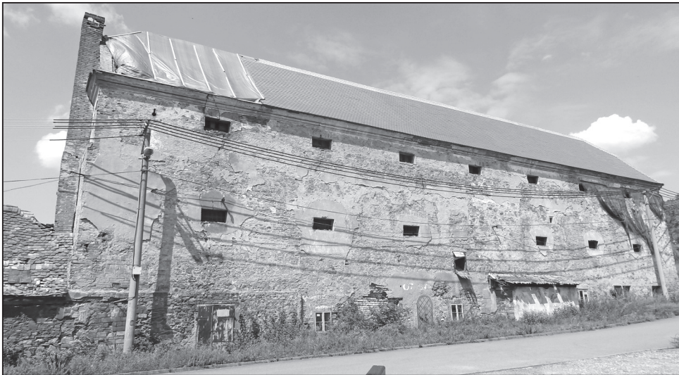
Pohled na objekt od východu ukazuje, že střecha je již téměř opravená, Louka 2015. Foto D. Hodeček.
