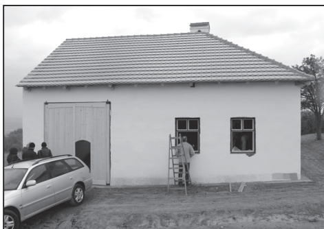
Instalace oken a vrat na zemědělské usedlosti z Boršic. Foto J. Káčer, fotoarchiv Parku Rochus, o.p.s., 2015.
