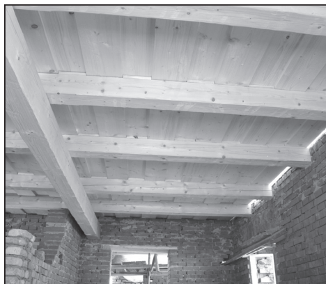
Položení záklopového stropu v objektu z Veletin. Foto J. Káčer, fotoarchiv Parku Rochus, o.p.s., 2015.
