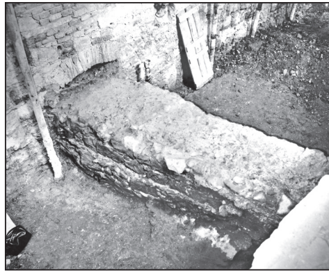
Pozdně středověké zdivo kláštera odkryté pod východním křídlem ambitu, pohled ze severozápadu, 1991. Fotoarchiv Slovákckého muzea v Uherském Hradišti, inv. č. 36316.
