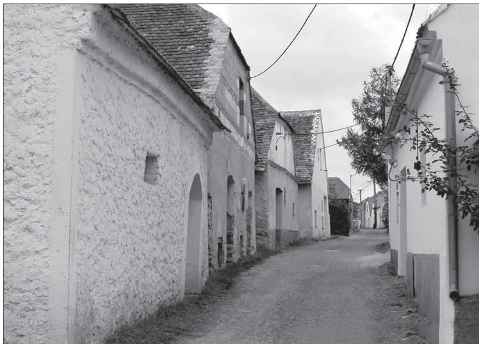
Areal vinohradnických sklepů v Hnanicích.
