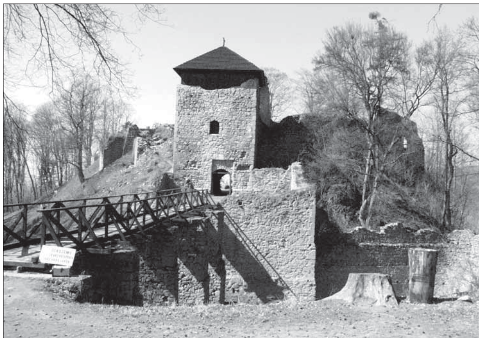
2. Pohled na jádro hradu Lukova s pozdněgotickou vstupní branskou věží.
