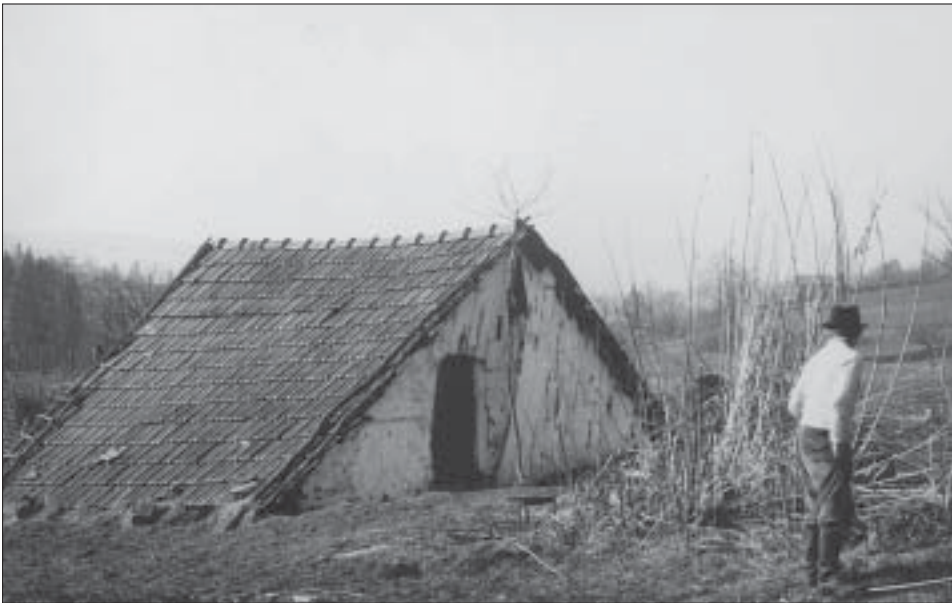
3. Polozemnice - pohled od východu na čelní stěnu.
