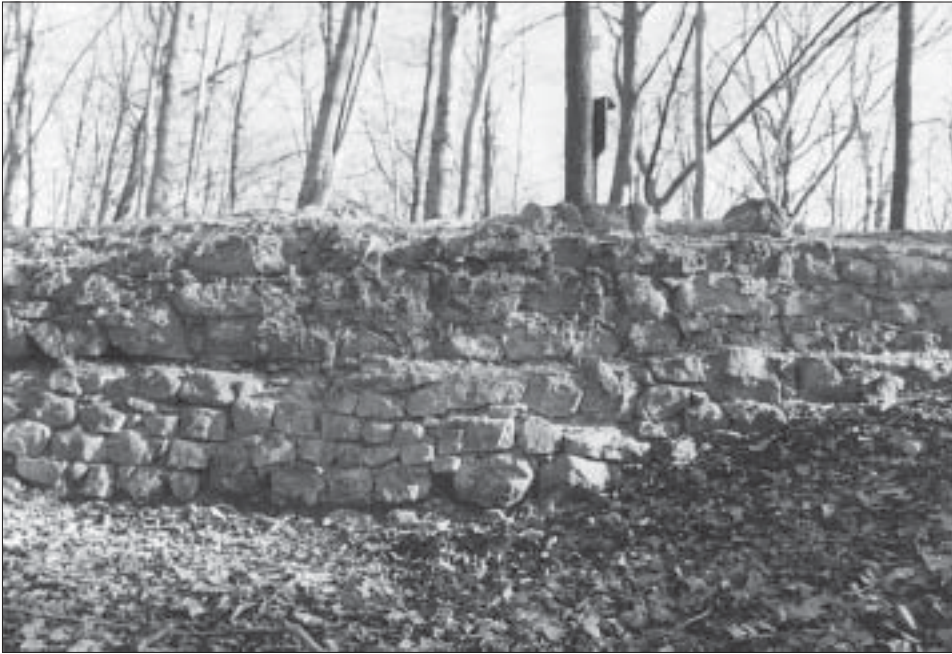
5. Starý Světlov, část vnějšího líce západní části parkánové hradby jádra; sokl zdiva je rozšířený, na horní části zbytky vápenných líček – pohled od severozápadu.
