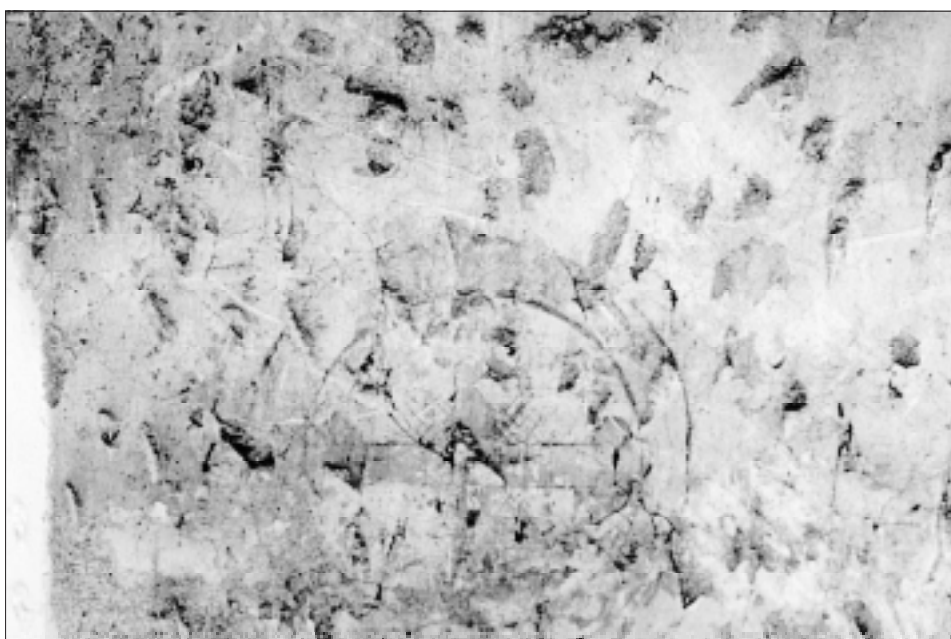
18. Kostel Zvěstování Panny Marie – malba světčího kříže v presbytáři.
