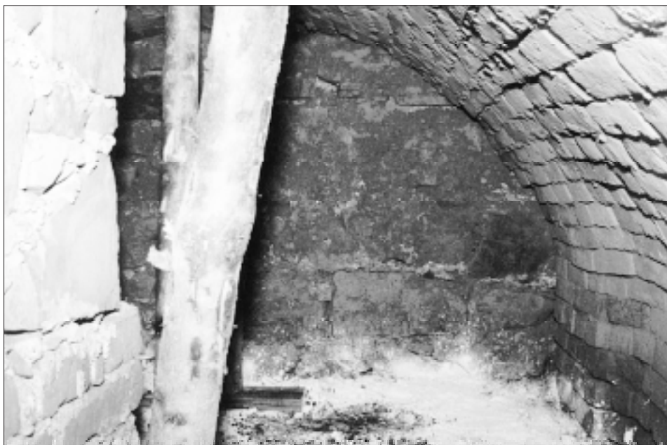
15. Kostel Zvěstování Panny Marie – vnitřní prostor krypty 8, vzadu západní stěnu objektu tvoří základy chrámové lodi.
