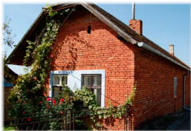
Štítově orientované stavení z režných cihel čp. 65
