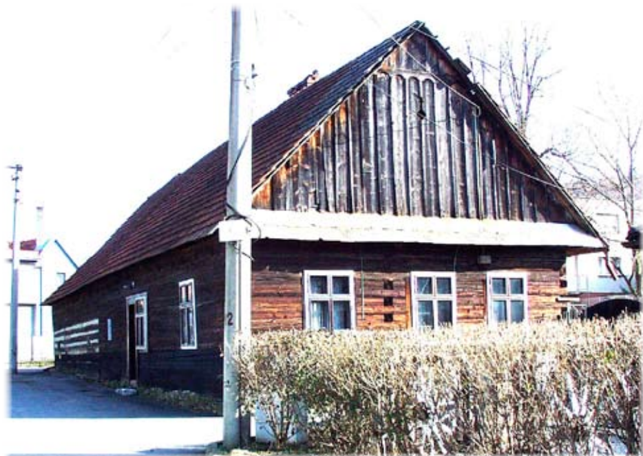
Roubená, okapově orientovaná usedlost čp. 30
