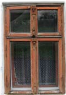
Okno zemědělské usedlosti čp. 69
