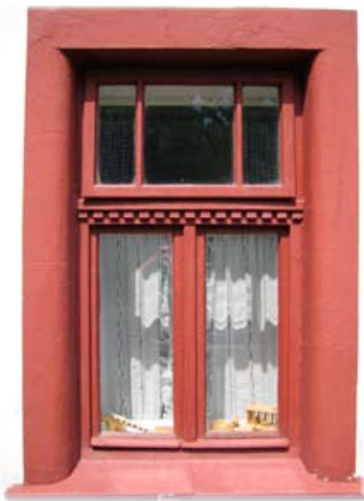
Detail okna usedlosti čp. 95
