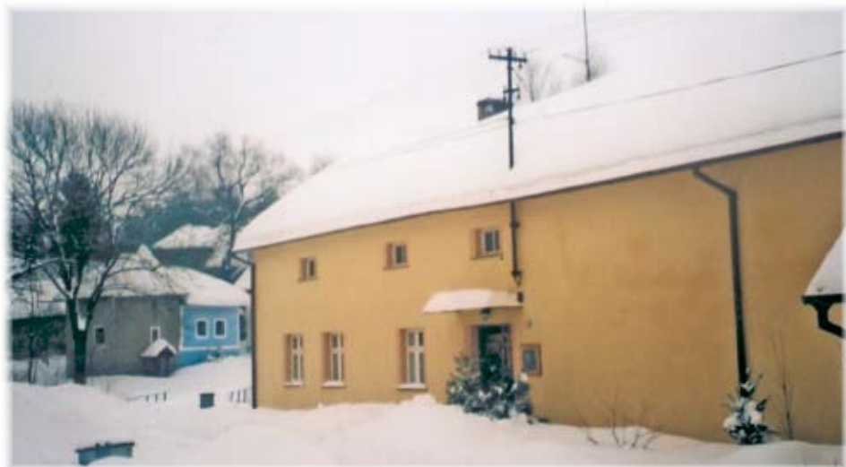
Pohled na tradiční zástavbu obce, v popředí usedlost čp. 8, v pozadí čp. 23 s komorou srostlou s domem
