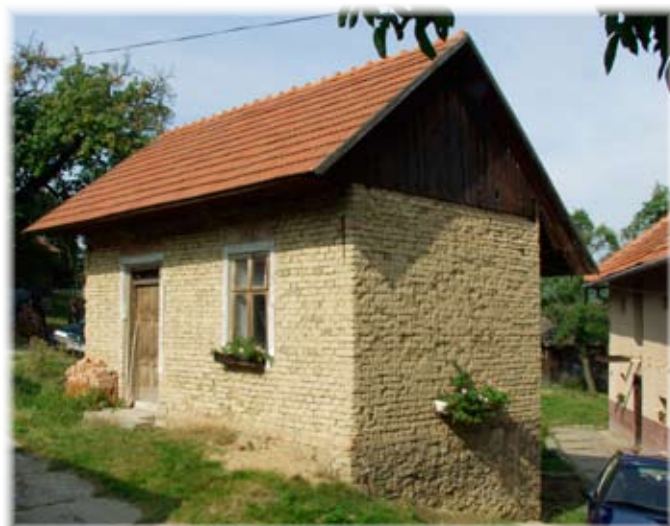
Komora z nepálených cihel ve dvoře domu čp. 40
