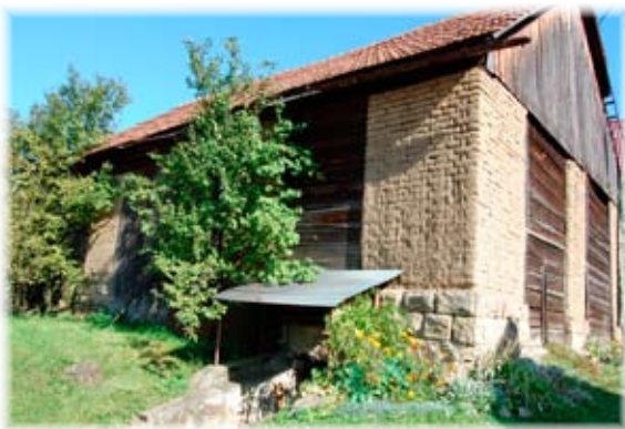
Pilířová stodola z nepálených cihel a s deskovými výplňmi
