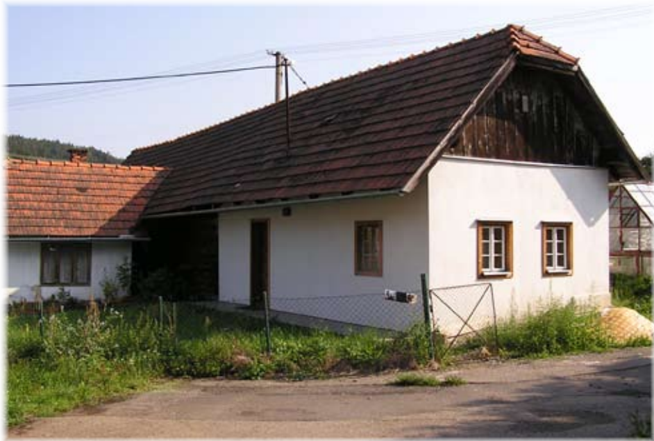
Šítově orientované stavení čp. 1
