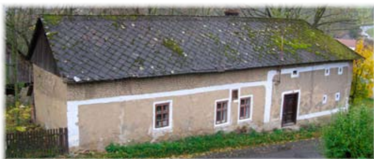
Zemědělská usedlost čp. 69 s patrovou komorou
