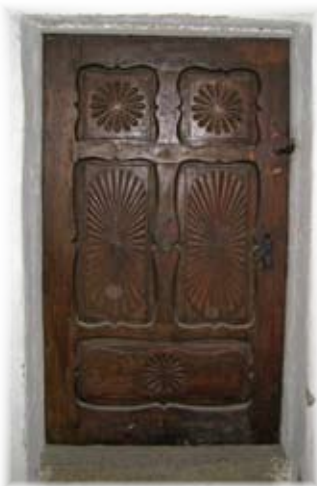
Usedlost čp. 6, detail dveří s řezbou v sýpkovém polopatře
