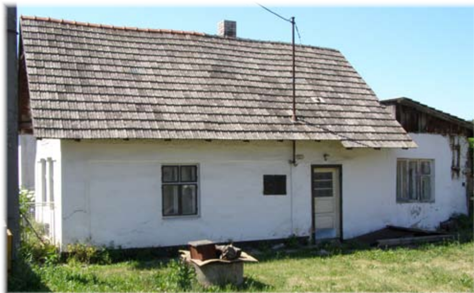
Podélná strana štítového stavení čp. 7
