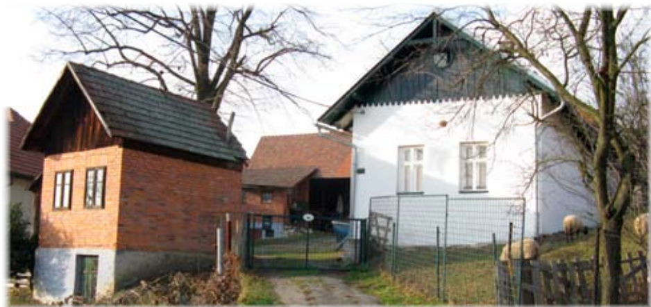
Štítově orientovaná usedlost čp. 32 s obytnou novostavbou původní komory
