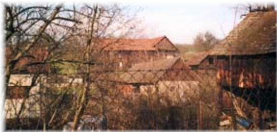
Zástavba dvorů se stodolami
