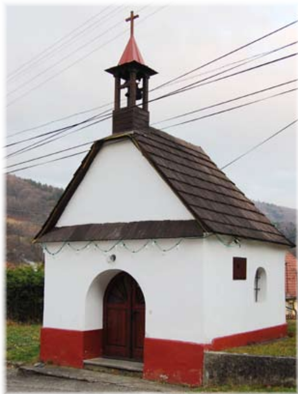
Památkově chráněná kaple P. Marie Hostýnské, střecha kaple nedůstojně zapletená ve zmeči drátů
