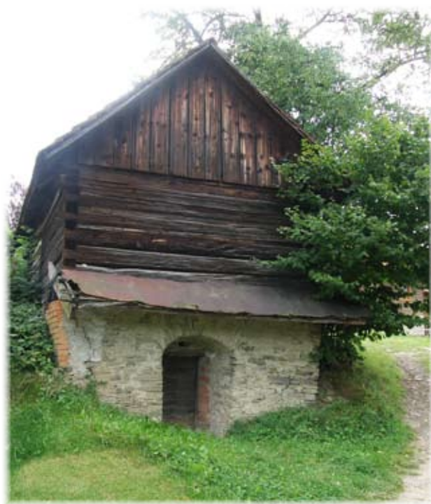
Roubená sušárna ovoce na kamenném sklepě u čp. 120
