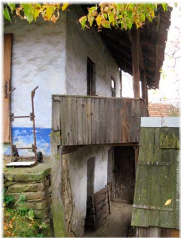
Samostatně stojící dvoupodlažní komora u čp. 24 s dřevěnou patrovou pavlačí
