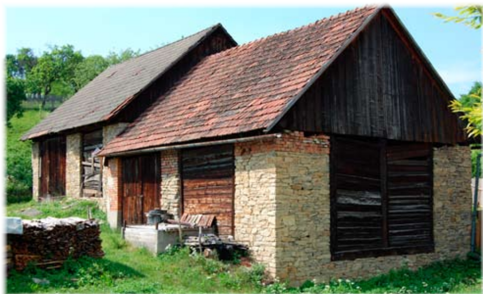
Kamenné stodoly - pilířové s deskovými výplněmi
