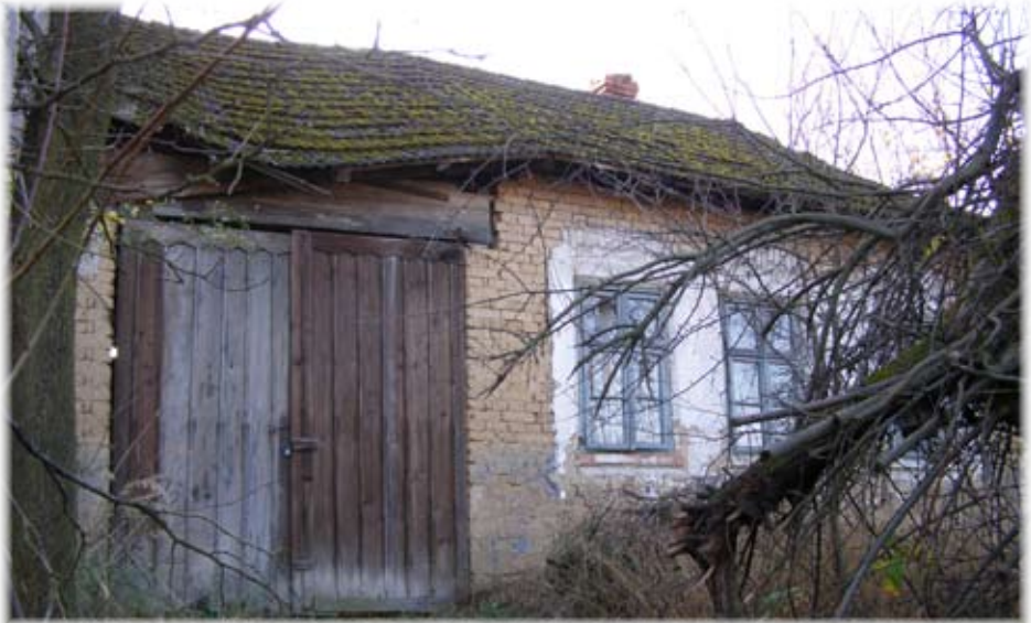
Usedlost přestavěná v první polovině 20. století
