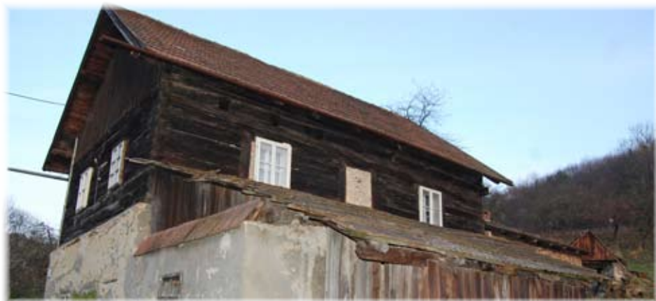
Roubený objekt čp. 155, původně vodní náhon elektrárny pro sklářskou hut'
