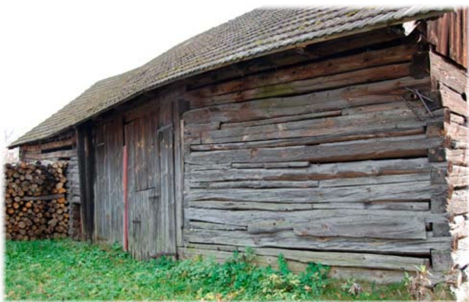
Roubená, příčně průjezdná stodola ve svahu nad obcí
