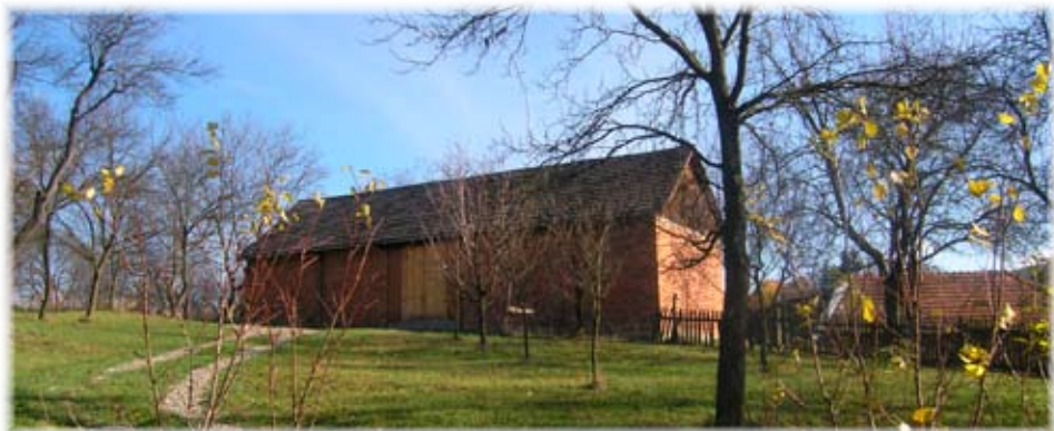
Zděná, příčně průjezdná stodola na kraji humna
