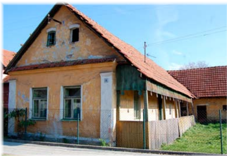
Štítově orientovaná zděná chalupa čp. 30 s otevřeným podsíňkem
