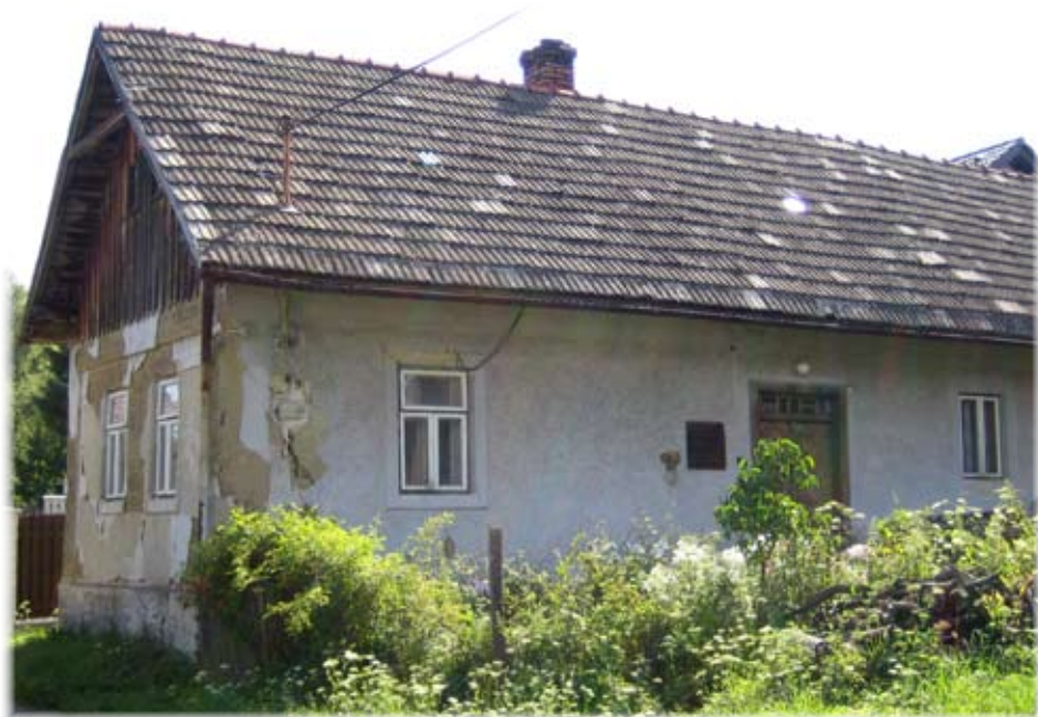
Štítové stavení čp. 4
