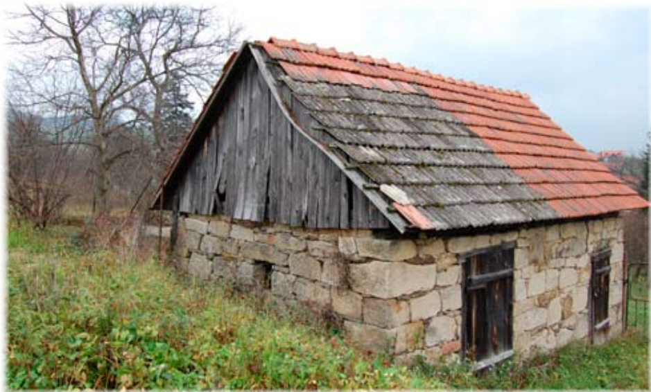
Sušárna ve svahu nad obcí, na konci humen, postavená z velkých kamenných kvádrů
