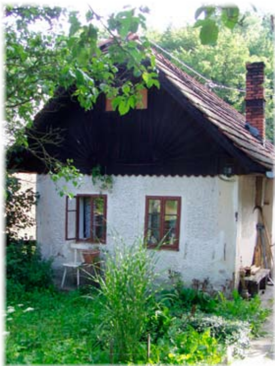
Roubený a omítnutý štítově orientovaný dům čp. 9
