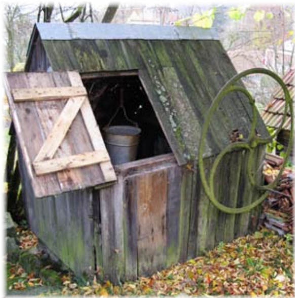
Studna s bedněným krytím a rumpálem u čp. 24
