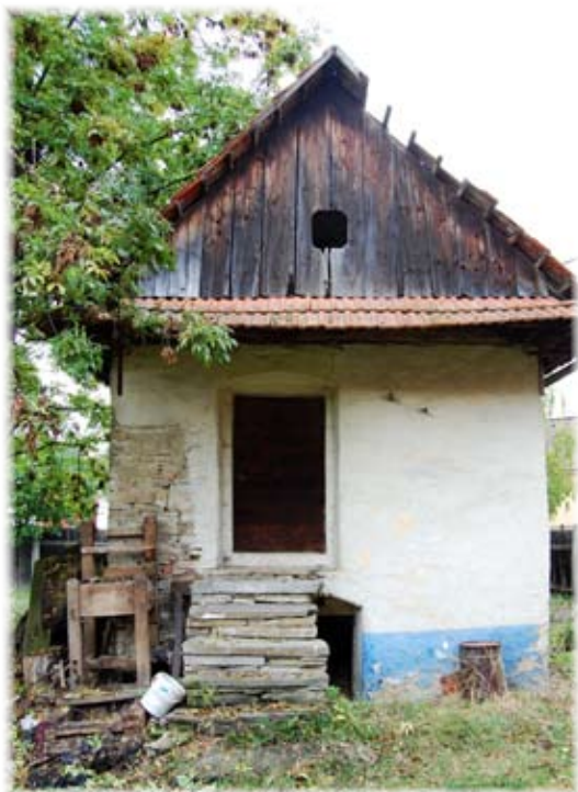
Komora ve dvoře usedlosti čp. 69
