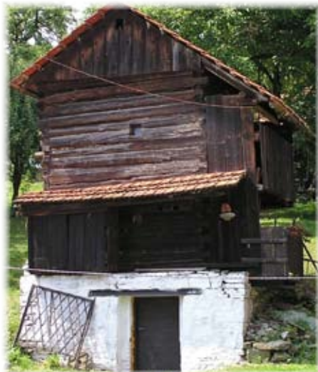
Komora u domu čp. 27
