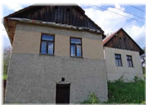
Štítově orientovaná průčelí domů čp. 80 a 82 v Žilíně
