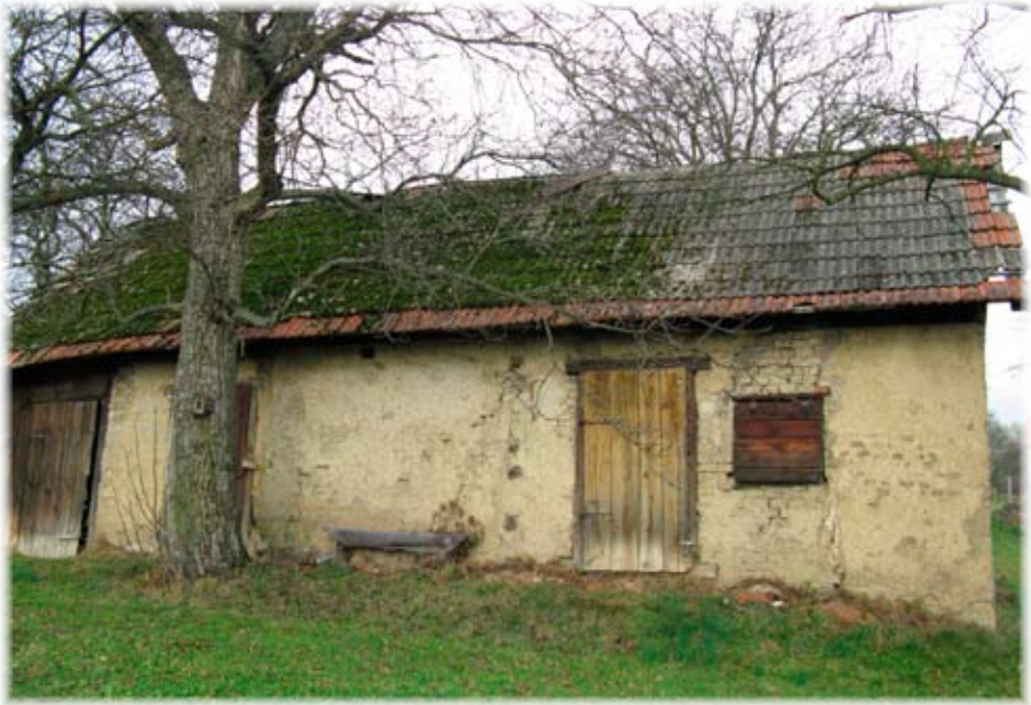
Sušárna z nepálených cihel na kamenném základě v humně za čp. 60
