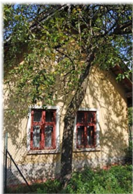
Šítově orientované stavení čp. 5
