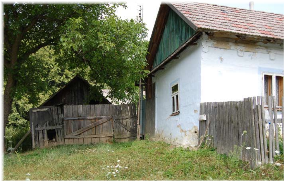
Roubené stavení čp. 1
