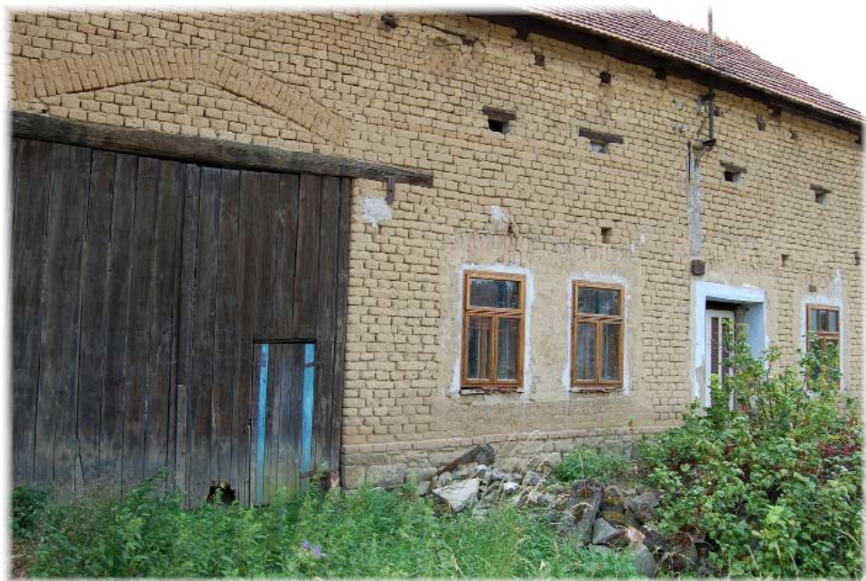
Usedlost z režného zdiva na návsi
