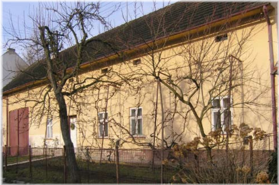
Usedlost s okapovou orientací
