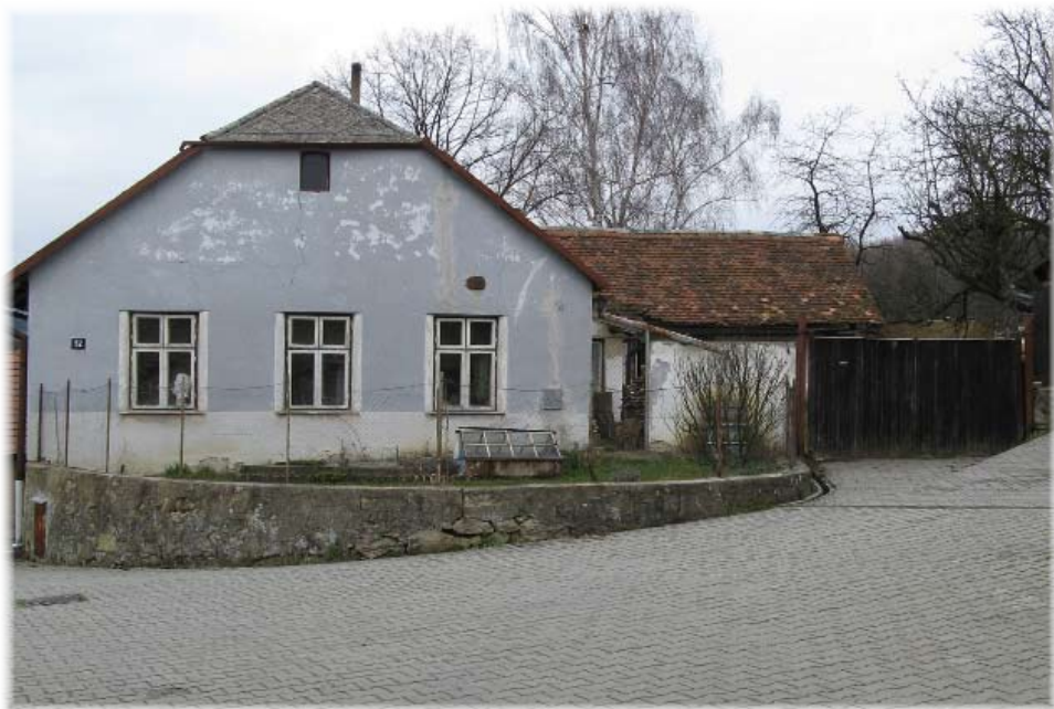
Domkářské stavení čp. 52
