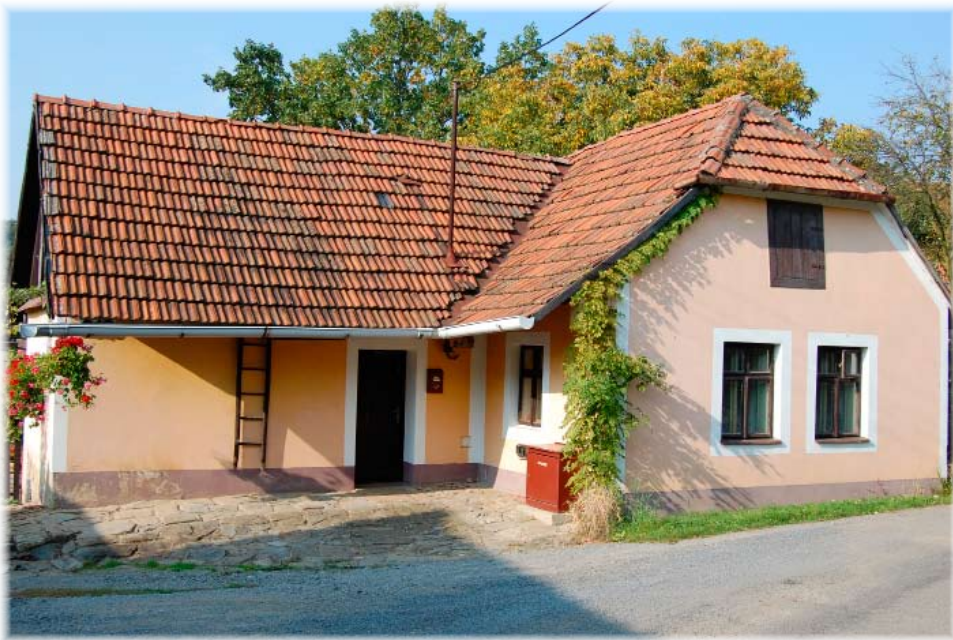
Domkařské stavení čp. 313
