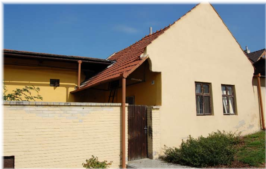
Domkařské stavení čp. 10
