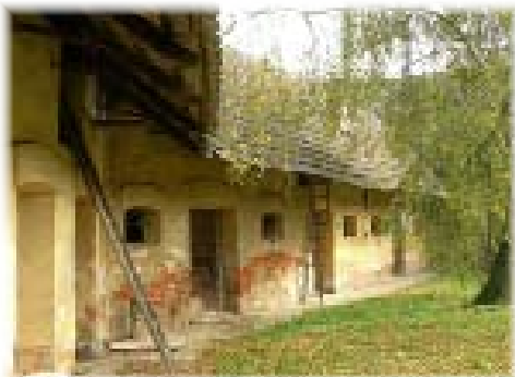
Zástavba chlévů ve dvoře
