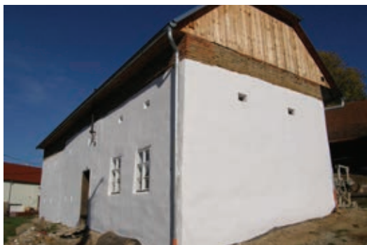
Současný stav objektu čp. 37
