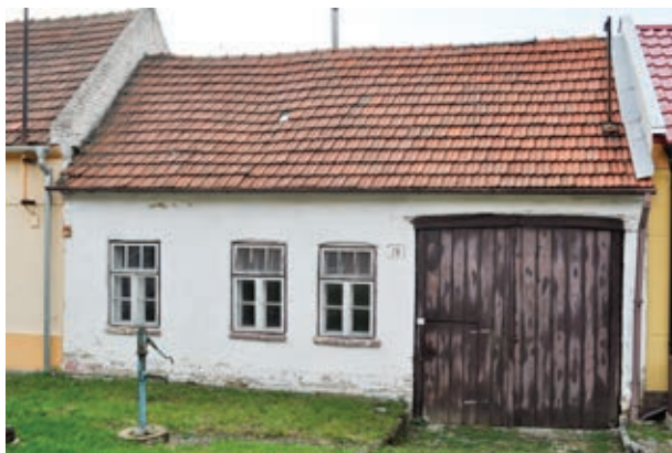
Průčelí usedlosti čp. 210
