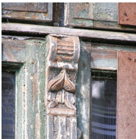
Detail okna domu čp. 4
