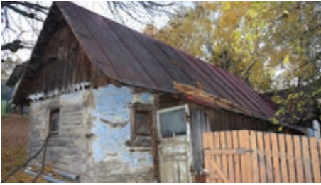
Roubené stavení čp. 25 z 19. století
