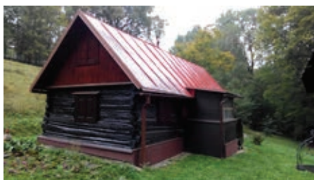
Roubený domek čp. 41 nevhodně natřený silnou vrstvou laku. Slouží jako rekreační chalupa, stav v roce 2017
