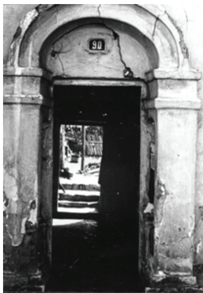
Žudro usedlosti čp. 90 před rekonstrukcí v roce 1975
