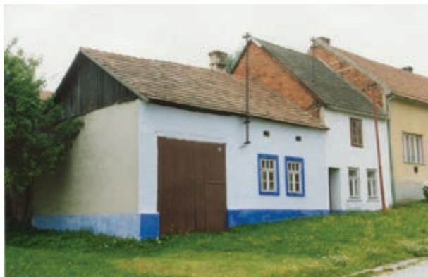
Usedlost čp. 216 a 327 zv. Štrbákovec - před obnovou
