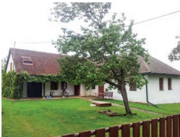
Rekonstruovaná usedlost čp. 5
