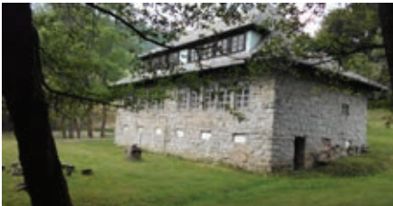
Opravovaný původní objekt školy v části Výškovské Bošáčky
