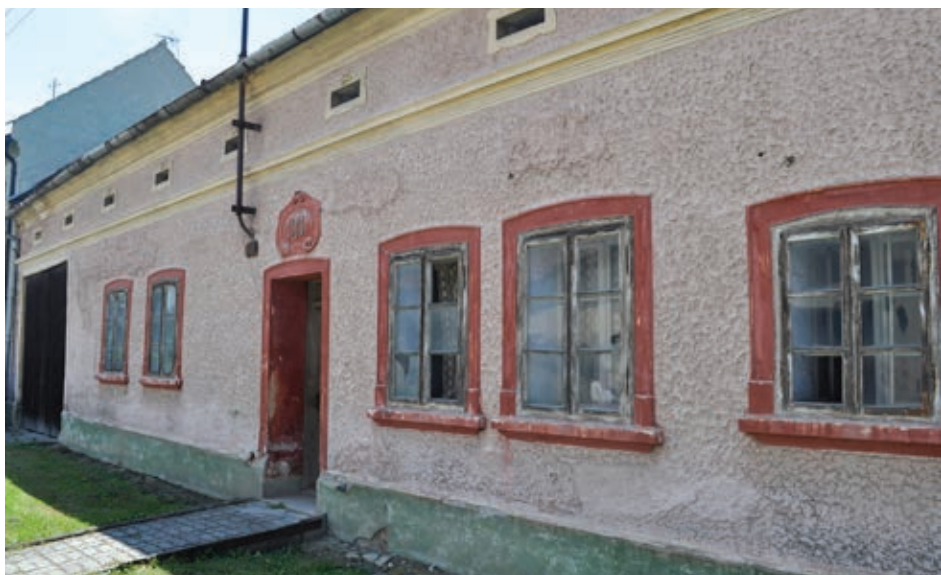
Původní podoba usedlosti čp. 131 s osobitou fasádou od Jana Beneše
