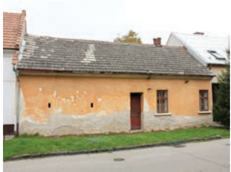
Část původní zemědělské usedlosti čp. 39 v ulici Svatovítská
