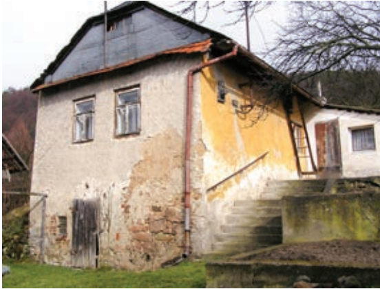
Nadsklepní dům čp. 68, stav v roce 2007
