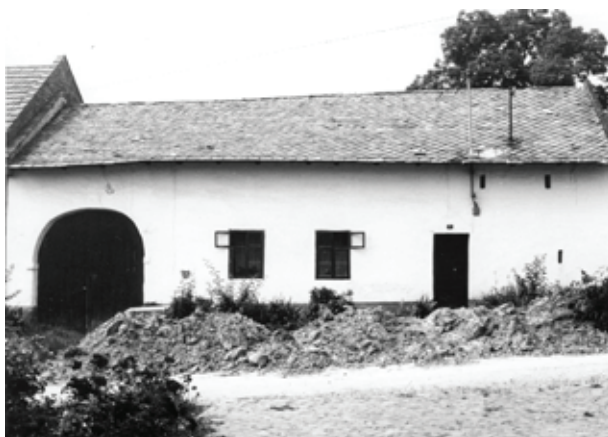
Původní zemědělská usedlost čp. 7, stav v roce 1975
