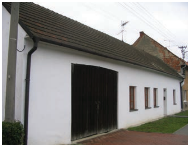
Obytné stavení čp. 291
