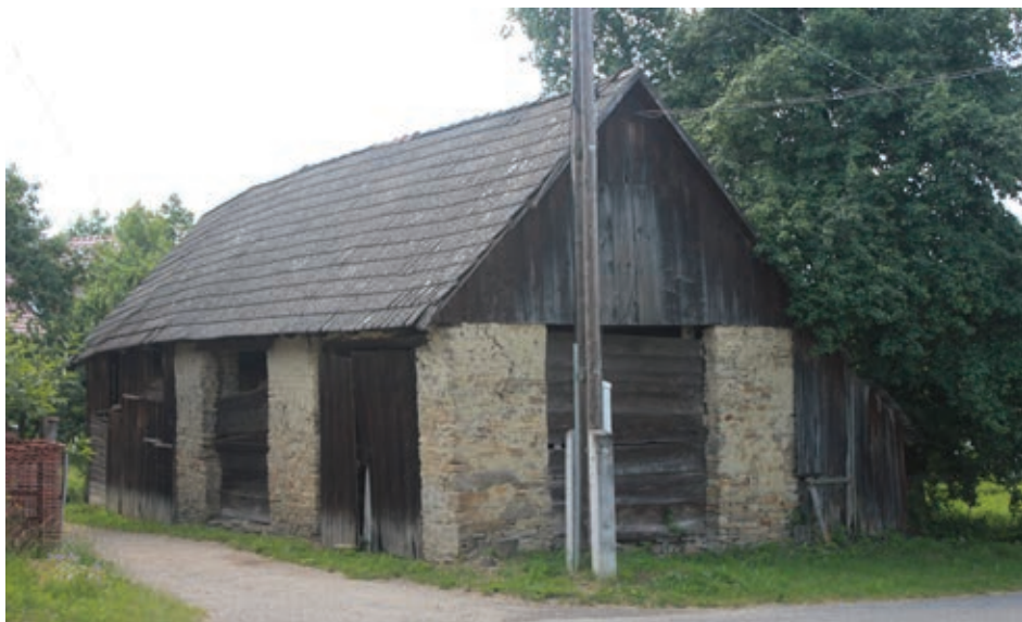
Stodola pod čp. 20 s kamennými pilíři a dřevěnou výdřevou
