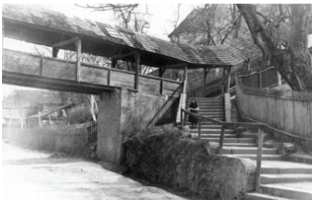
Krytý most z fary ke kostelu, okolo roku 1918
