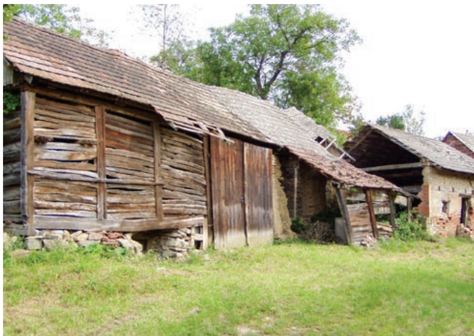
Hospodářské stavby za čp. 1 v roce 2007
