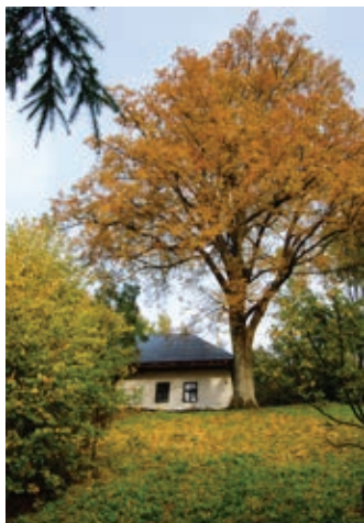
Stavení čp. 28, stav v roce 2007
