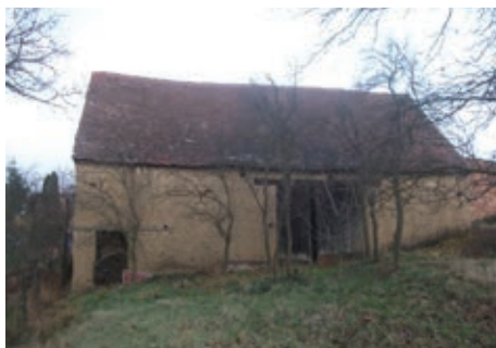
Velká stodola z hliněných cihel v humně domu čp. 81
