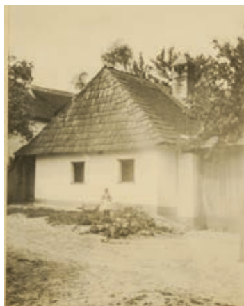
Původní usedlost krytá šindelem, okolo roku 1932
