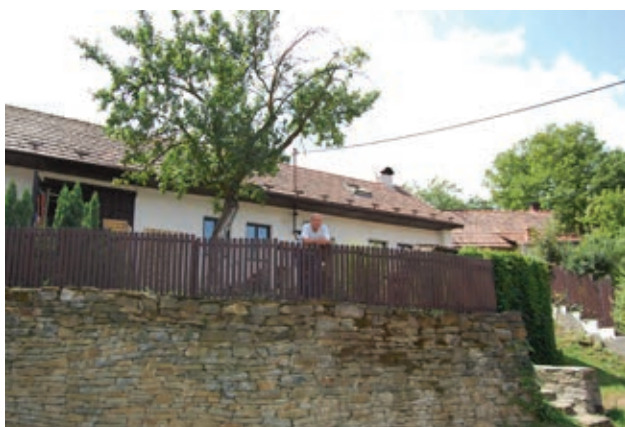
Využití kamene pro opěrnou zeď terasy
