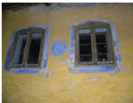
Detail segmentově zaklenutých oken venkovského stavení čp. 138
