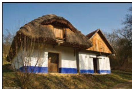
Stavebně obnovené vinohradnické budy
