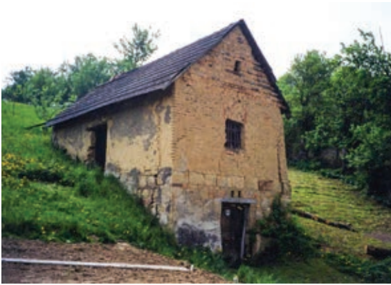
Podsklepená komora u Abrhámů za čp. 55
