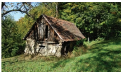
Roubená sušárna ovoce u čp. 146, stav v roce 2007
