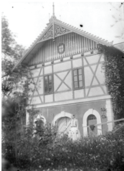
Původní barokní nadsklepní dům s hrázděním ve Vinohradské ulici čp. 368 pochází z roku 1740, stav v roce 1896
