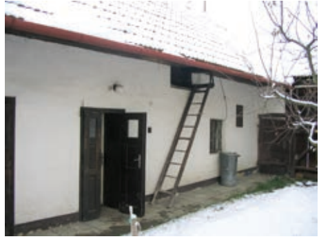
Pohled do dvorní části bývalého statku čp. 123
