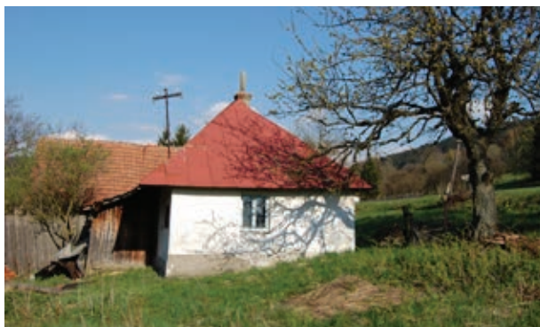
Štítově orientované stavení čp. 6
