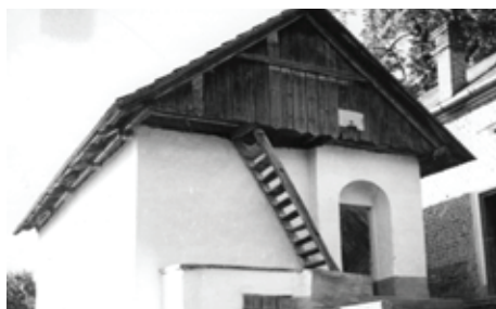
Původní patrová komora v obci, stav v roce 1943
