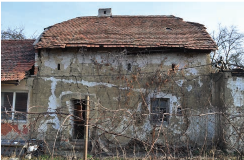
Původní výměnek z roku 1844 ve dvoře usedlosti čp. 81
