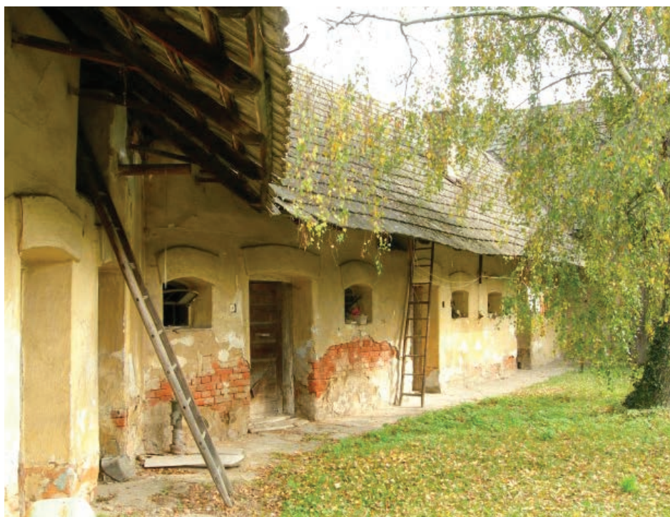
Dochovaný hospodářský trakt čp. 162 s chlévy a pumpou
