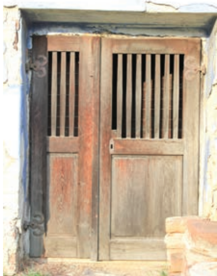
Detail dveří do sklepa domu parc. č. 1008
