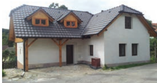
Domkařské stavení čp. 313 v roce 2007 a dnes
