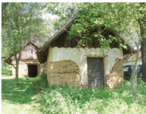
Vinohradnické budy v Soví hoře jsou postaveny z hlíny technologii nabíjení
