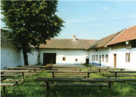
Dvůr usedlosti čp. 90 přeměněný v komorní amfiteátr
