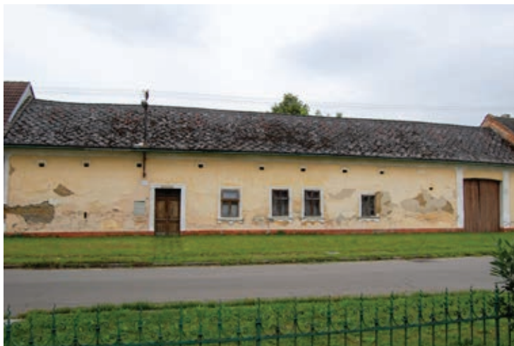
Současný stav usedlosti čp. 15
