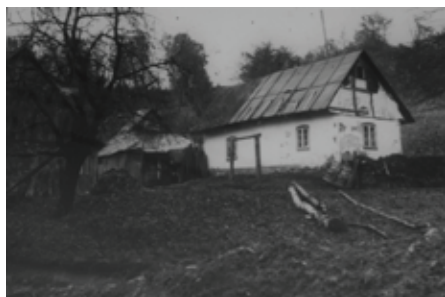
Stav ruiny usedlosti čp. 40 před rekonstrukcí
