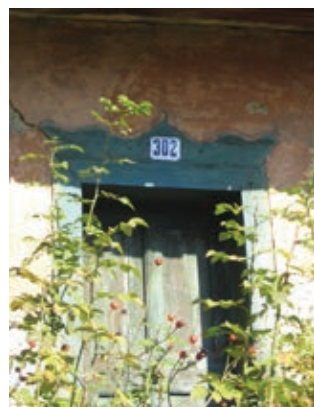
Domkařské stavení čp. 302 v části Potok – detail vstupu s nadpražím a plastickým orámováním
