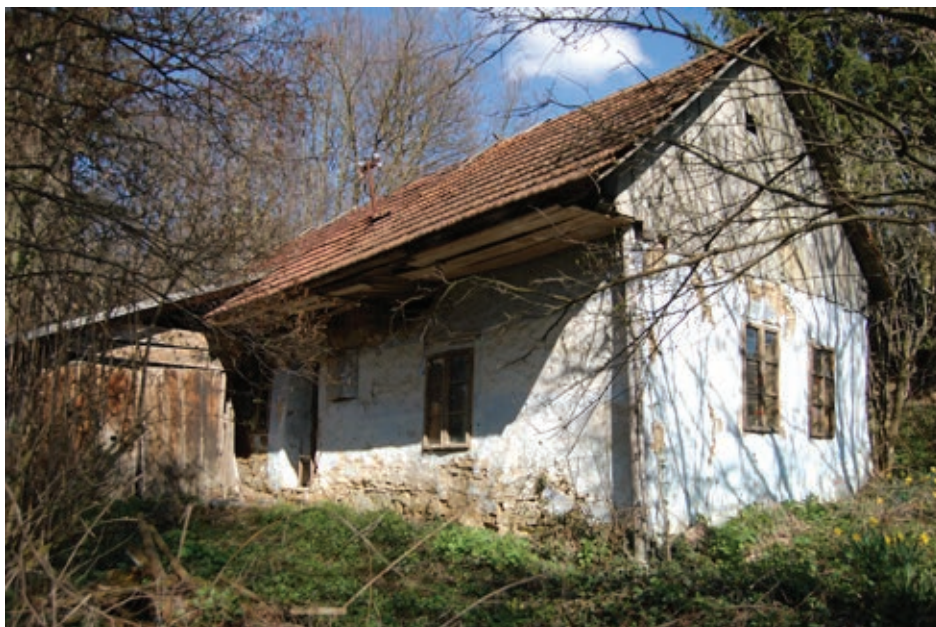
Štítově orientované stavení čp. 240, stav v roce 2007
