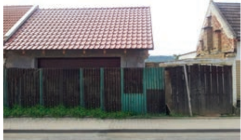
Stavení čp. 75 v roce 2008 a dnes
