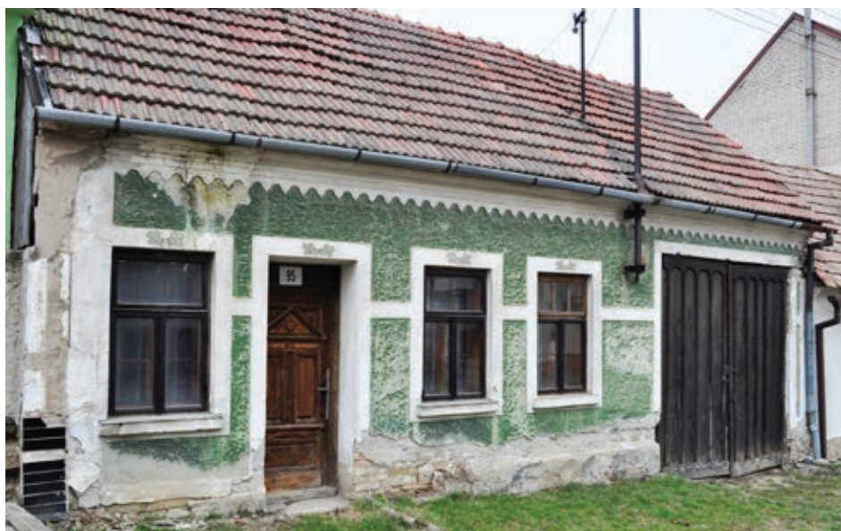
Čelní pohled na usedlost čp. 95
