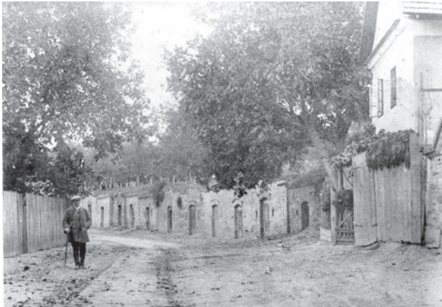
Pohled na vinné sklepy v Polešovicích, okolo roku 1918–1938
