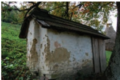
Pec na chleba u usedlosti čp. 68 zůstala zachovaná v původní podobě, stav v roce 2007
