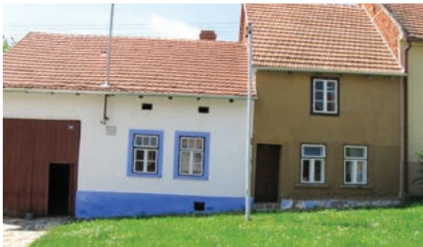
Usedlost čp. 216 a 327 zv. Štrbákovec po obnově
