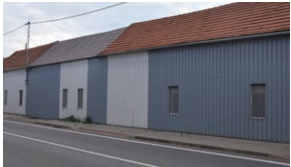
Současný stav objektu čp. 371.
