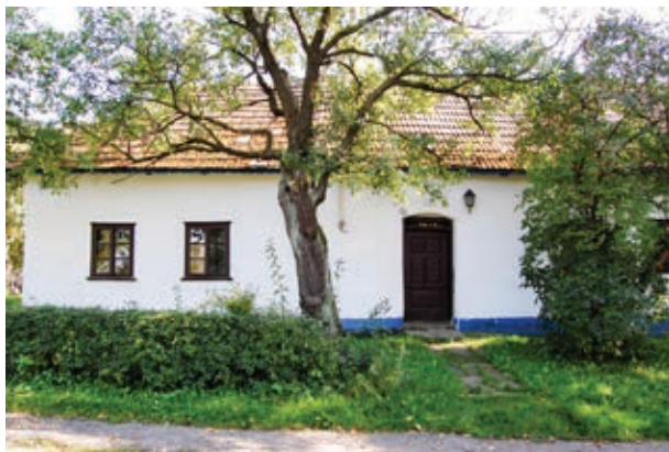
Průčelí usedlosti čp. 11
