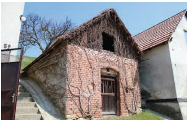
Sklep z režných cihel u čp. 61
