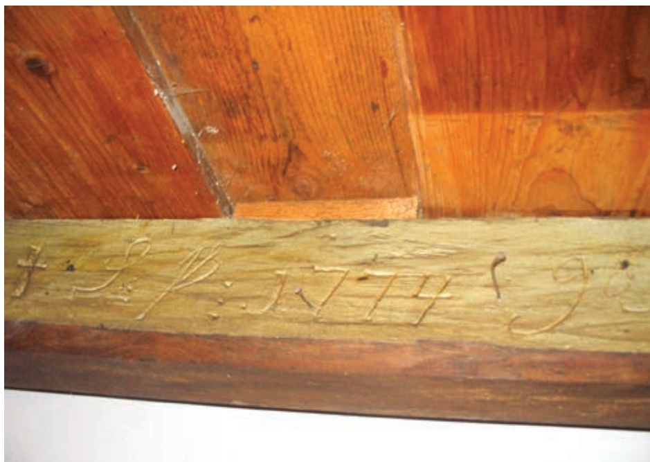
Vročení 1774 na trámu v interiéru v domě čp. 66
