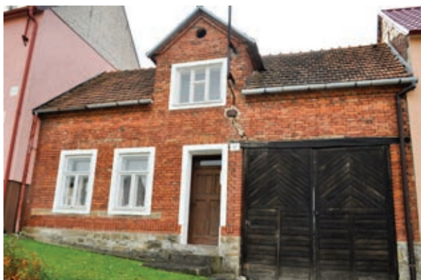
Průčelí usedlosti čp. 47 z pálených cihel
