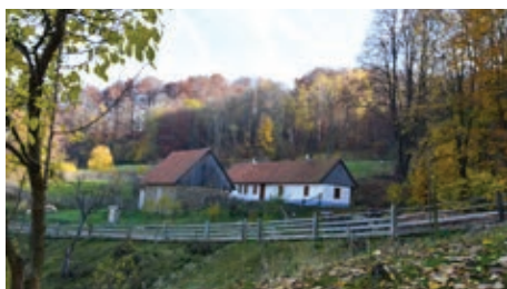
Nově a příkladně zrekonstruovaná usedlost čp. 40, původní stavba pochází z 80. let 19. století
