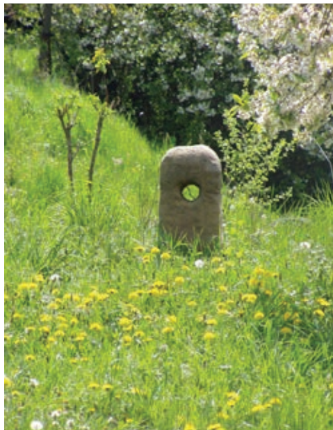
Detail větracího průduchu sklepa, tzv. rampůch
