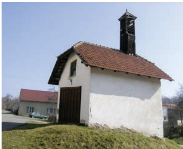
Hasičská zbrojnice na návsi
