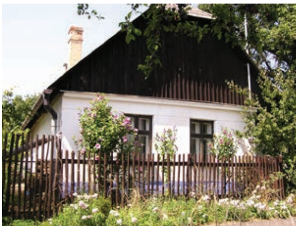
Usedlost čp. 183 v části Paseky
