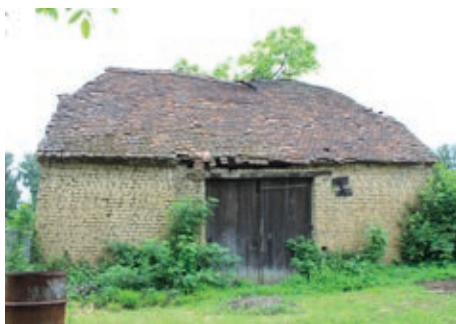
Hliněná stodola za domem čp. 537
