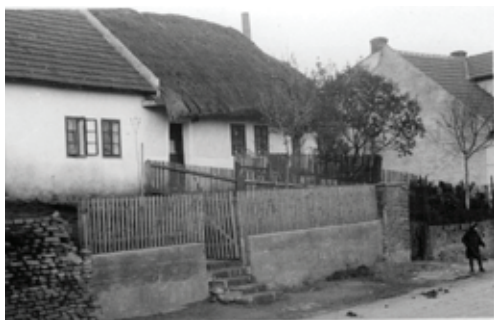
Dům s doškovou střechou v řadové zástavbě s dřevěnými ploty
