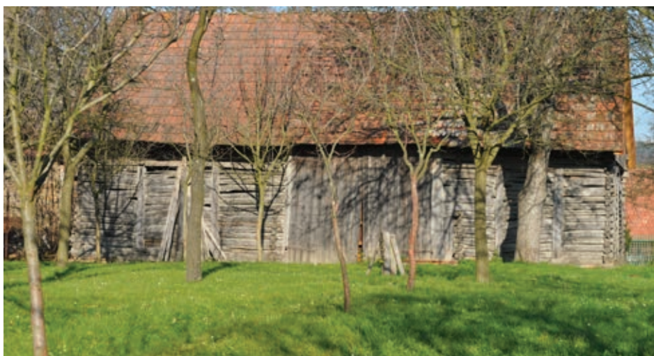
Dřevěná stodola z kombinovaných technik
