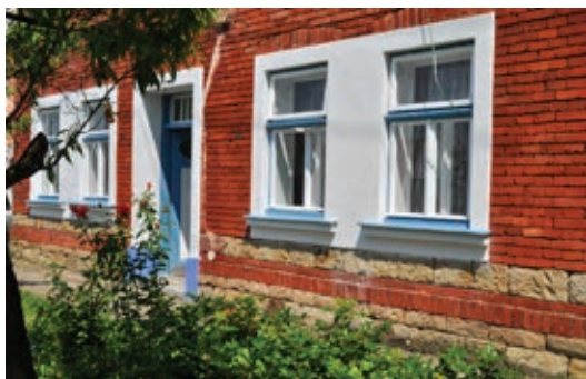
Detail průčelí domu čp. 776, kombinace kamene a pálené cihly
