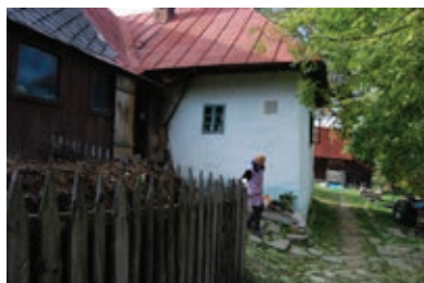
Tradiční kompletně zachovaná usedlost čp. 68 z nepálené hlíny – nabíjenice, stav v roce 2007
