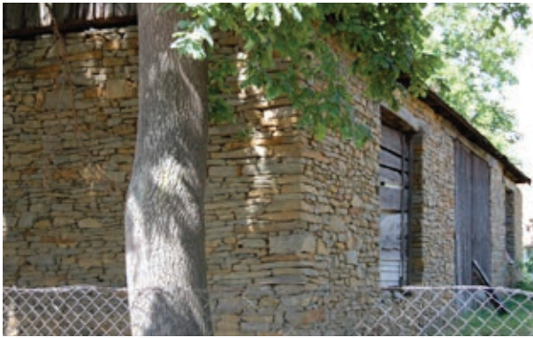
Kamenná stodola za usedlostí čp. 77 před rekonstrukcí
