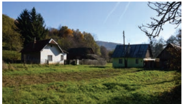
Soubor objektů na čp. 79, současný stav
