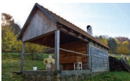
Nově zbudovaný objekt sušírny ovoce u zrekonstruované usedlosti čp. 40
