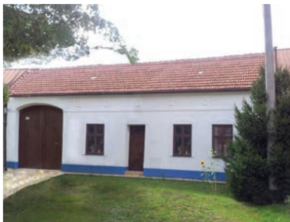
Nově rekonstruovaná usedlost čp. 20 na návsi
