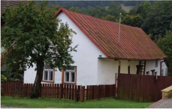
Štítově orientované stavení čp. 103
