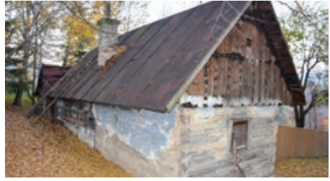
Roubené stavení čp. 25 z 19. století
