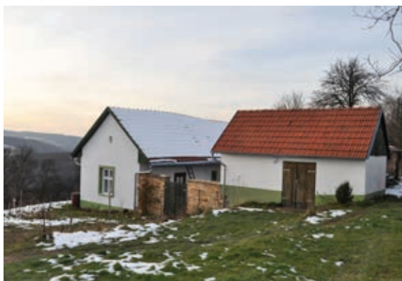
Usedlost čp. 150 ztratila opravou svůj původní ráz
