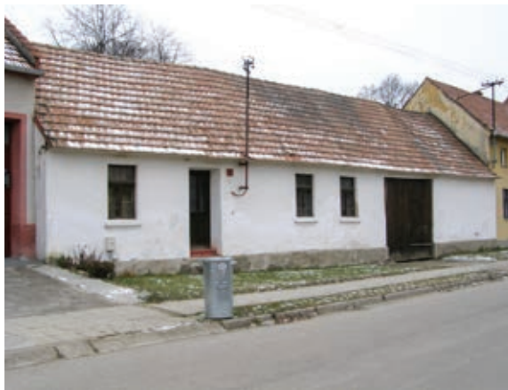
Zemědělská usedlost čp. 72, stav v roce 2008
