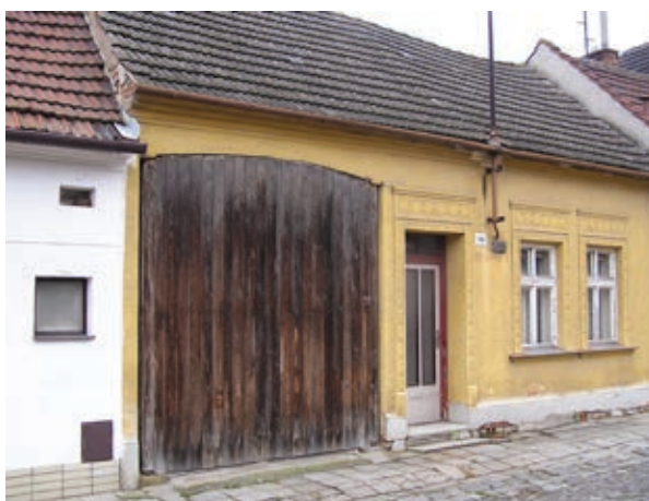
Původní stav domu čp. 149 v roce 2007
