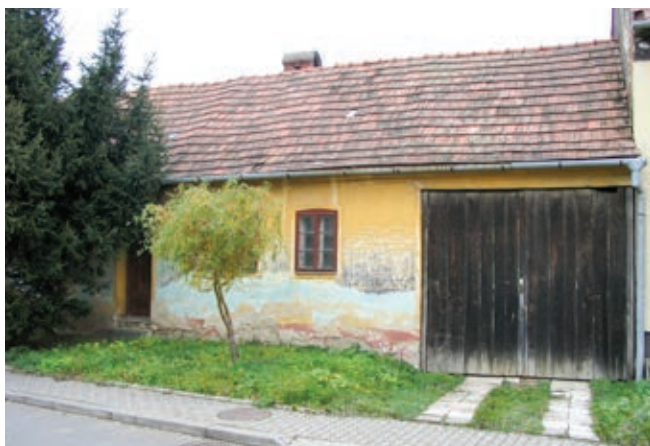
Průčelí stavení čp. 152
