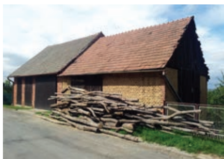
Stodoly z pálených a nepálených hliněných cihel
