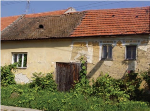
Dnes již nestojící původní dvojdům čp. 80, ve kterém byla hospoda. Průčelí bylo bohatě zdobeno štukem, stav v roce 2007
