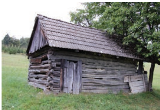
Roubená sušárna na ovoce na usedlosti čp. 212
