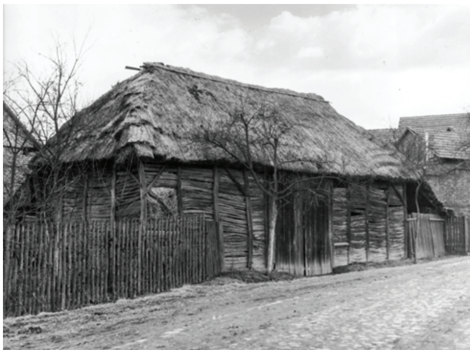
Původní dřevěná sloupková stodola krytá valbovou střechou s doškem, foceno 1967
