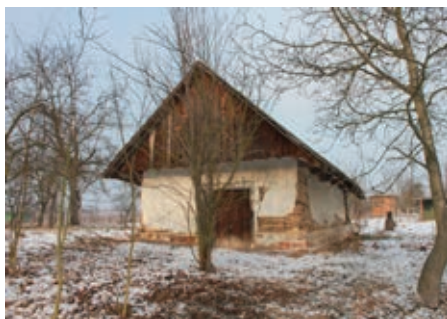
Vinohradnická bída na parcele č. 269, stav v roce 2012
