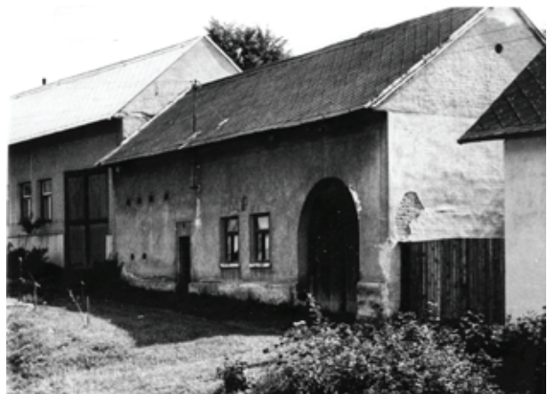
Původní zemědělská usedlost čp. 93, stav v roce 1975
