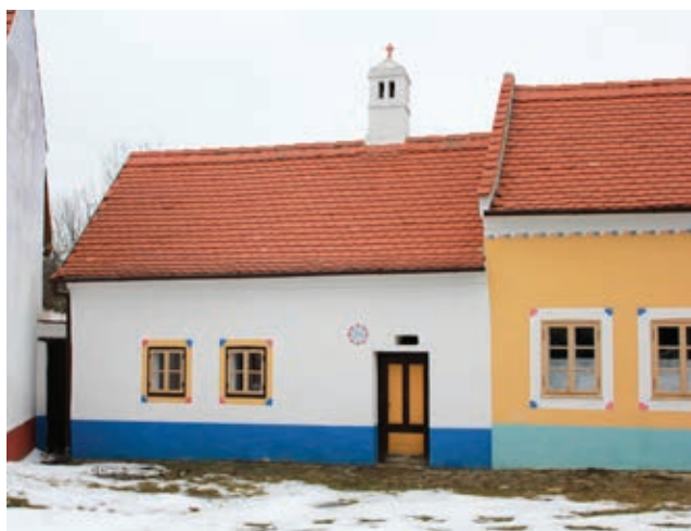
Současný stav domu čp. 284 po rekonstrukci
