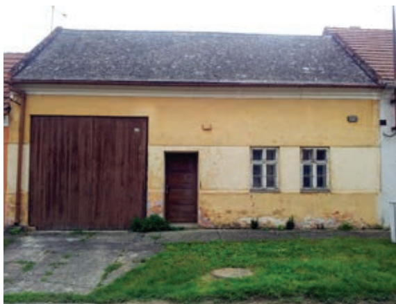
Stavení čp. 395 v Dolní ulici
