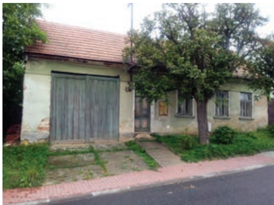
Dochované průčelí domu čp. 102
