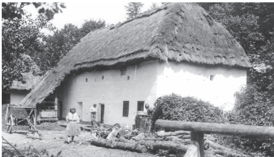
Původní usedlost se zvýšeným polopatrem krytá doškovou krytinou, stav v roce 1925
