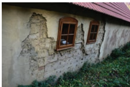
Nově a příkladně zrekonstruovaná usedlost čp. 40, zadní strana domu
