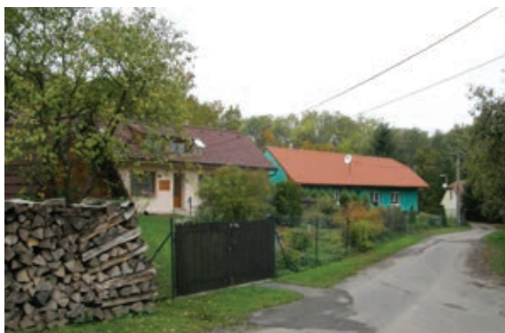
Dům čp. 95, stávající stav 2017
