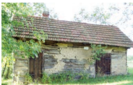
Roubená sušárna ovoce omazaná hlinou
