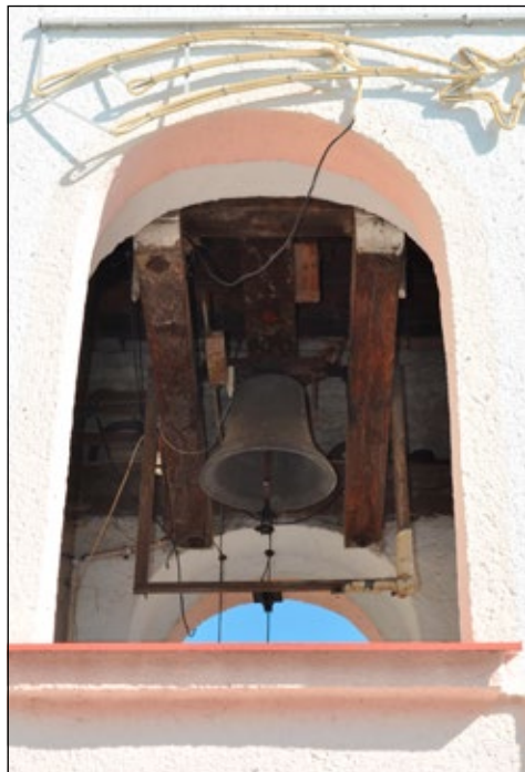
Závěs zvonu ve zvonici v Žeravínách, 2021. Foto J. Káčer. Fotoarchiv SM UH.
