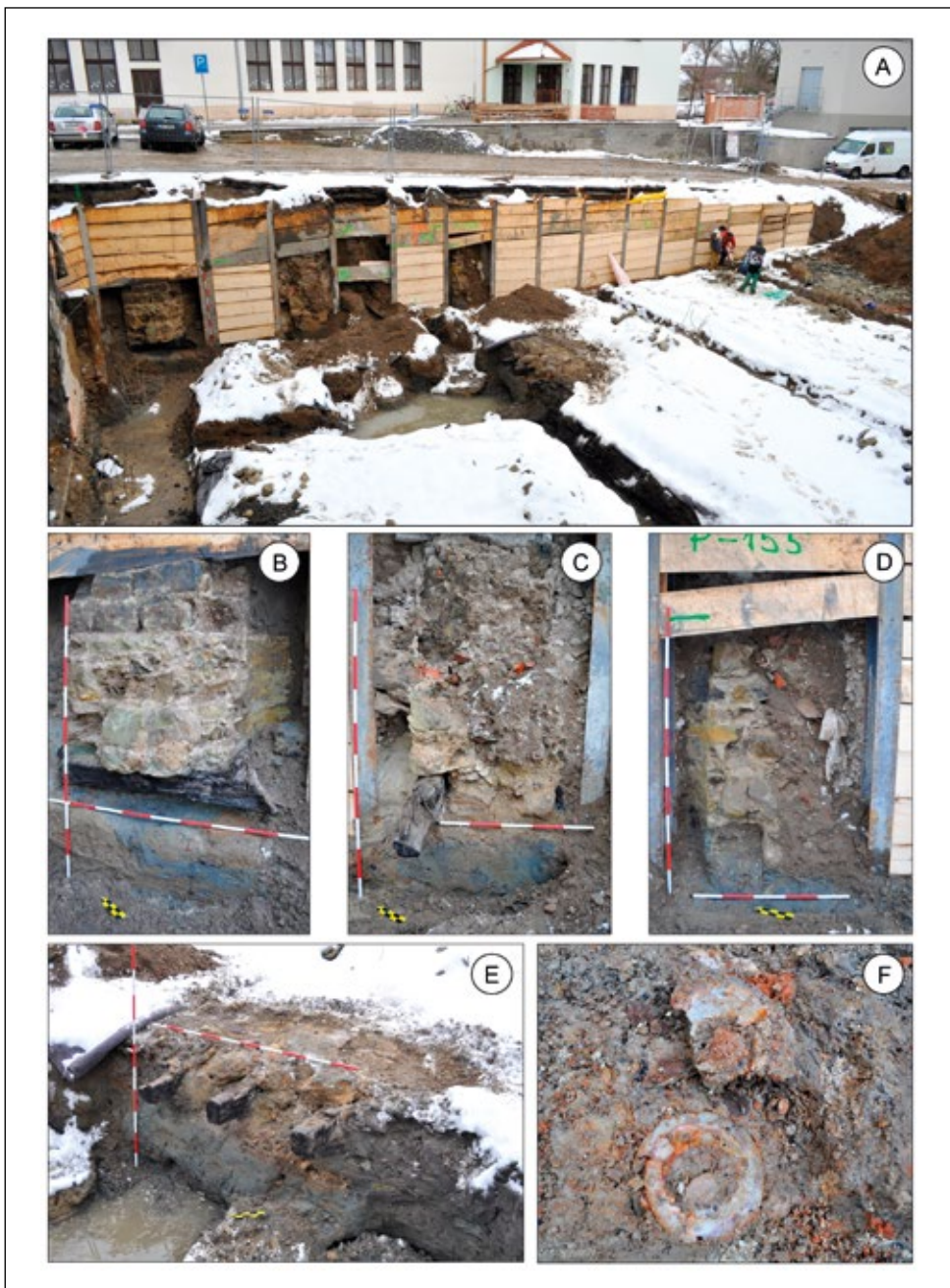
Obr. 29. Uherské Hradiště, ulice Hradební. Stavební jáma v průběhu výzkum (A), relikty základového zdiva na východním profilu (B–D), rošt z dubových trámů (E), detail nálezu části skleněné nádoby v poloze in-situ (F). Foto J. Bartík.
