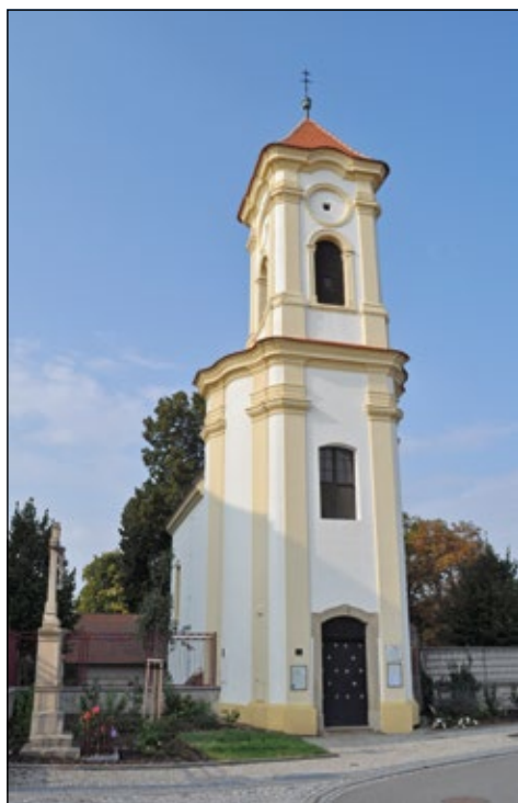
Kaple svatého Rocha s věžovou zvonicí ve Starém Městě ve Strážnici, 2021. Foto J. Káčer. Fotoarchiv SM UH.
