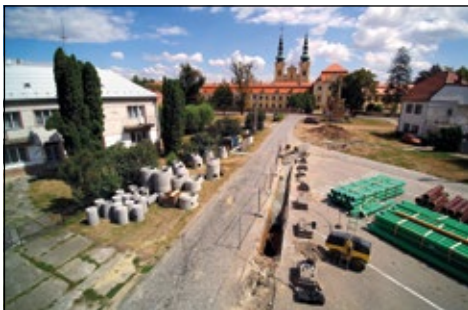
Obr. 20. Velehrad. Liniový výkop pro revitalizaci kanalizace v předpolí velehradského kláštera v roce 2018. Foto T. Chrástek.
