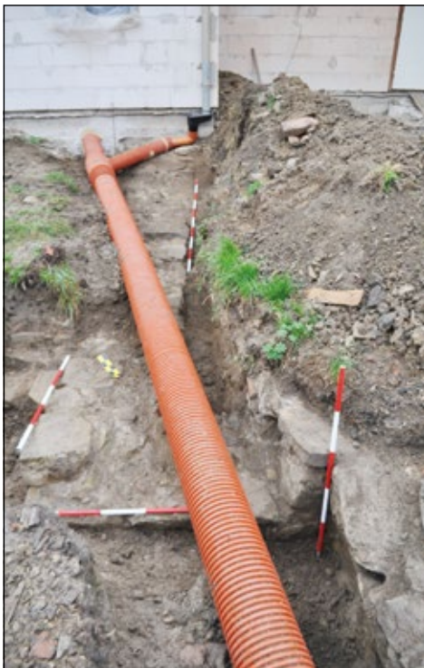
Obr. 3. Kněžpole. Relikty základového zdiva novověké hospodářské stavby. Foto J. Bartík.
