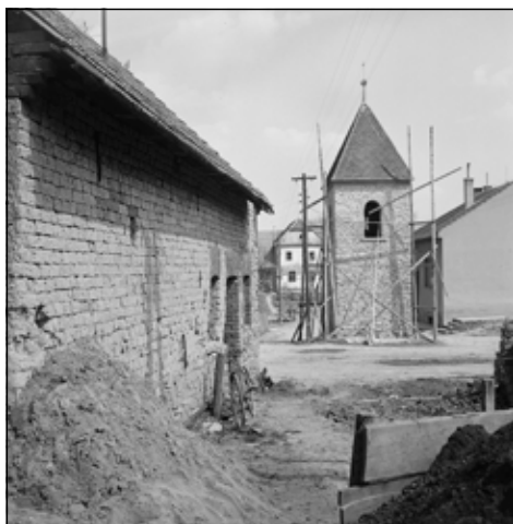
Zvonice v Hrubé Vrbce při opravě bez fasády, kde je krásně viditelné kamenné zdivo, 1970. Foto J. Tomeš. Fotoarchiv NÚLK.
