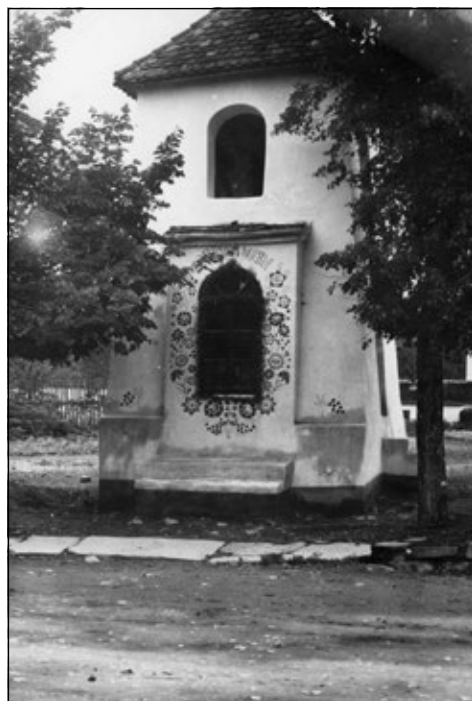
Zděná patrová zvonice v Louce, 1933. Fotoarchiv SM UH.
