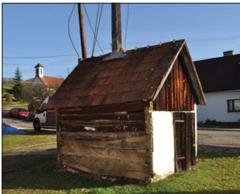
Roubená konstrukce zvonice na návsi v Kladné, 2019. Foto J. Káčer. Fotoarchiv SM UH.
