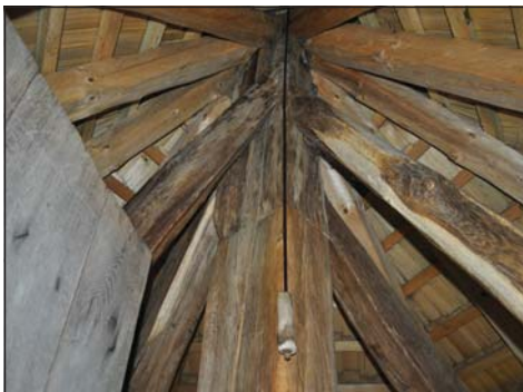
Detail interiéru zvonice v Haluzicích, 2019. Foto J. Káčer. Fotoarchiv SM UH.
