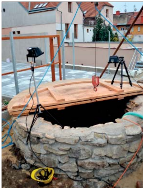
Obr. 3. Pohled na nadzemní část studny se závěsným zařízením, pomocí kterého byl vyvážen vytěžný sediment. Foto J. Bartík.
