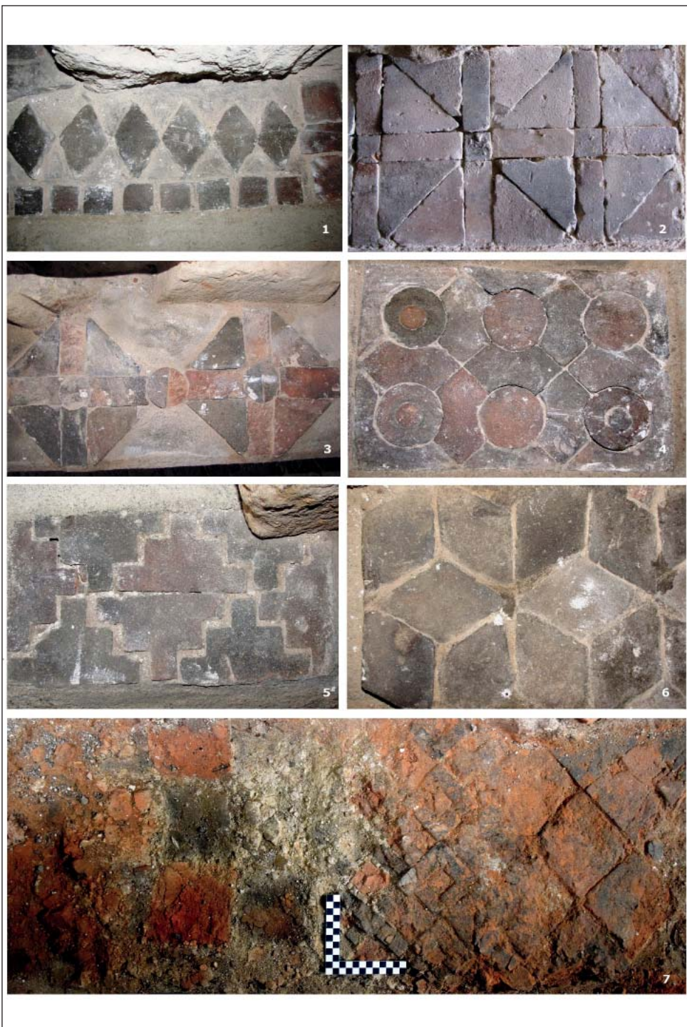
Obr. 2. 1–6 – Ukázky různých vzorů románské mozaikové dlažby prezentované na základě starších nálezů v kapitulní síni; 7 – Detail románské mozaikové dlažby odkryté v roce 2015 ve zjišťovací sondě S2 položené v místě zaniklého refektáře. Foto Z. Schenk.
