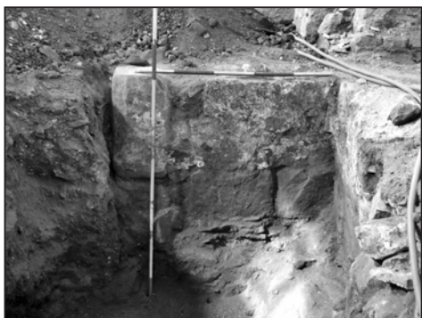
Obr. 1. Pohled na odkryté základy a část opěrného pilíře v jihozápadní části lodi kostela, 13. století. Foto M. Vaškových.
