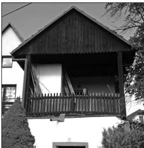
Nahoře nadsklepní buda v Prostřední hoře čp. 401, šedesátá léta 20. století, dole současný stav, Mařatice 2013. Fotoarchiv Slovákého muzea.
