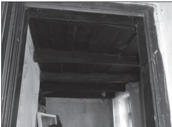
Pohled na trámový strop v usedlosti, s viditelným kladem do záklopu. Foto archiv autora.
