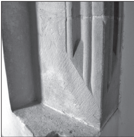
Obr. 11. Hrad Buchlov, trnož části ostění vstupního portálu do bývalé raně gotické kaple, pohled od severovýchodu, Buchlov 2012. Foto R. Vrla.
