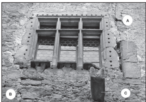
Obr. 7. Hrad Buchlov, detail západního okna rytířského sálu (místnost č. 24, srovnej obr. 4B); A – fragment ostění staršího okna (v původní poloze), B – druhotně přemístěný fragment ostění staršího okna, C – barokní výlečka; pohled od severu, Buchlov 2012. Foto R. Vrla.
