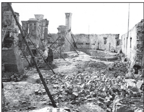
Obr. 12. Hrad Buchlov, historická fotografie půdy severního traktu po požáru v roce 1931, pohled od jihu; napravo je destruovaná partie při západní zdi hranolového rizalitu (je zde patrná sendvičová konstrukce zdiva, líc pravé části zdi je zřejmě opatřen omítkou). U paty levé části se rýsuje otisk po horizontálním trámu – průběh dřevěné konstrukce je dále vidět až téměř k severozápadnímu nároží v pozadí. Kolem okénka v průhledu (napravo od nároží) jsou patrné dva symetricky situované svíslé tmavší pásy (pravděpodobně opět jizvy po dřevěných konstrukcích). Dále vlevo je na vnější stěně patrná vodorovná tmavá linie (zdivo bez omítek). V popředí před vstupem do rizalitu je zachycena hromada suti ze zříceného zdiva, obsahujícího převážně vysoké cihly („prstovky“). Snímek z roku 1931. Fotoarchiv Národního památkového ústavu, územního odborného pracoviště v Brně.
