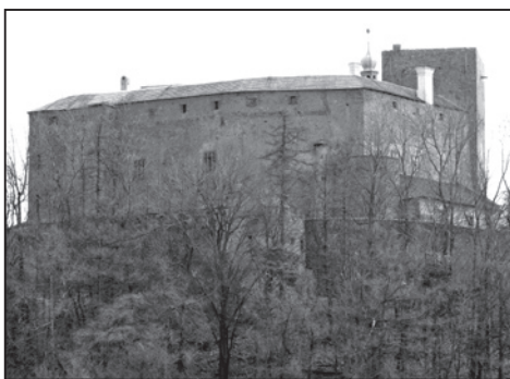
Obr. 1. Hrad Buchlov, severní část hradního jádra, pohled od severozápadu, Buchlov 2010. Foto R. Vrla.
