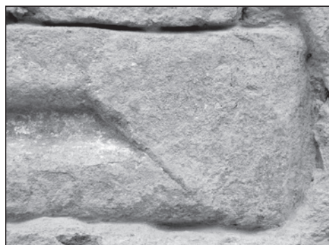
Obr. 5. Kaple Cyrilka, detail bloku č. 1 – trnož portálu s ukončením profilace, Velehrad 2012. Foto R. Vrla.
