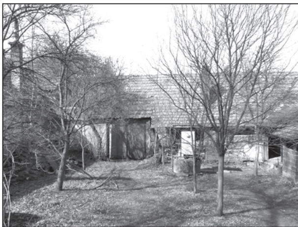
Zadní část usedlosti s úhlovou zástavbou dvora. Foto archiv autora.
