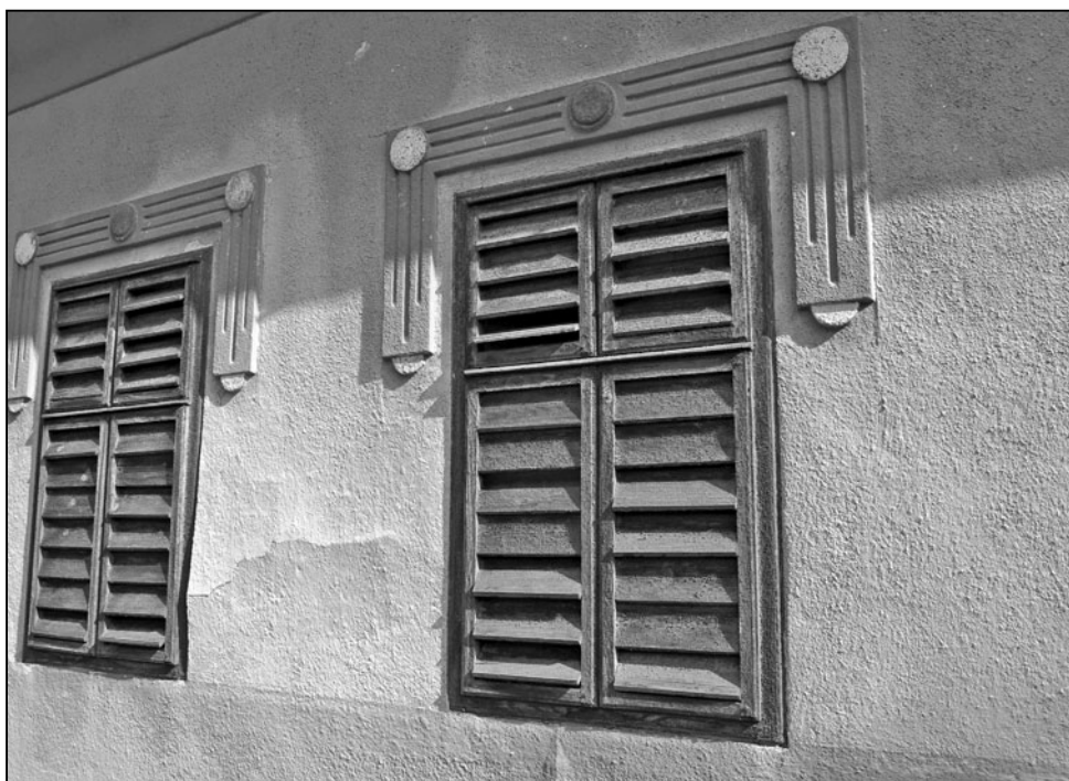
Detail oken od komory s dřevěnými žaluziemi usedlosti čp. 119, Roštín – náves.
