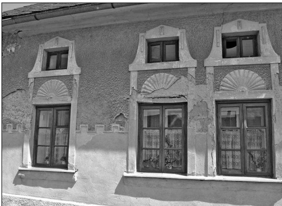
Usedlost čp. 45 se zajímavou štukovou výzdobou, Dřínov – náves.
