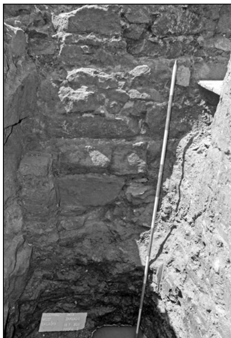
Obr. 12. Profil západní boční zdi mostu, Velehrad 2011. Foto T. Chrástek.
