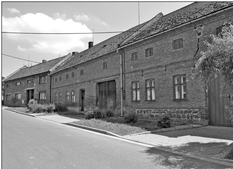
Zástavba usedlostí čp. 5, 6 a čp. 119 s režnou fasádou z pálených cihel, Dřínov.
