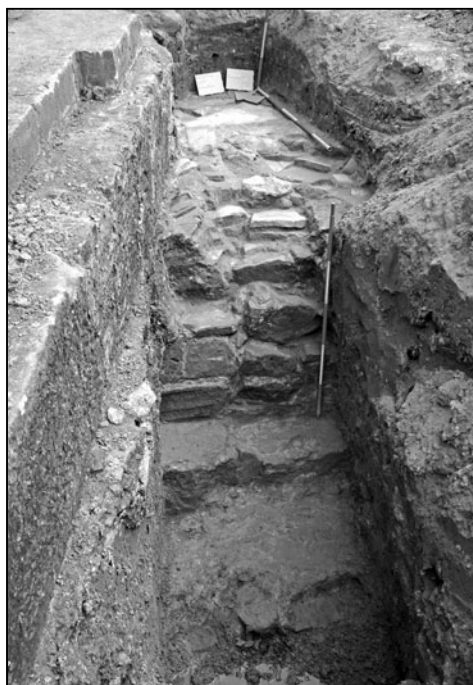
Obr. 8. Konstrukce oblouku mostu v sondě S2, pohled od jihu, Velehrad 2011. Foto M. Vaškovič.
