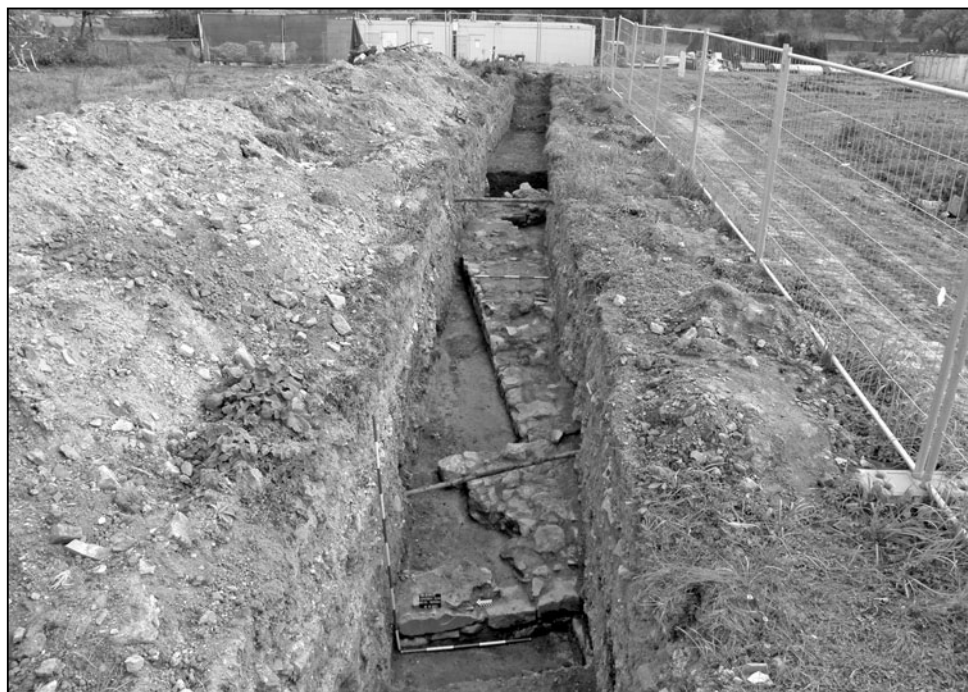
Obr. 18. Revizní sonda S1/2011 s odkrytými konstrukcemi jádra opatského domu. Pohled od západu, Velehrad 2011. Foto Z. Schenk.
