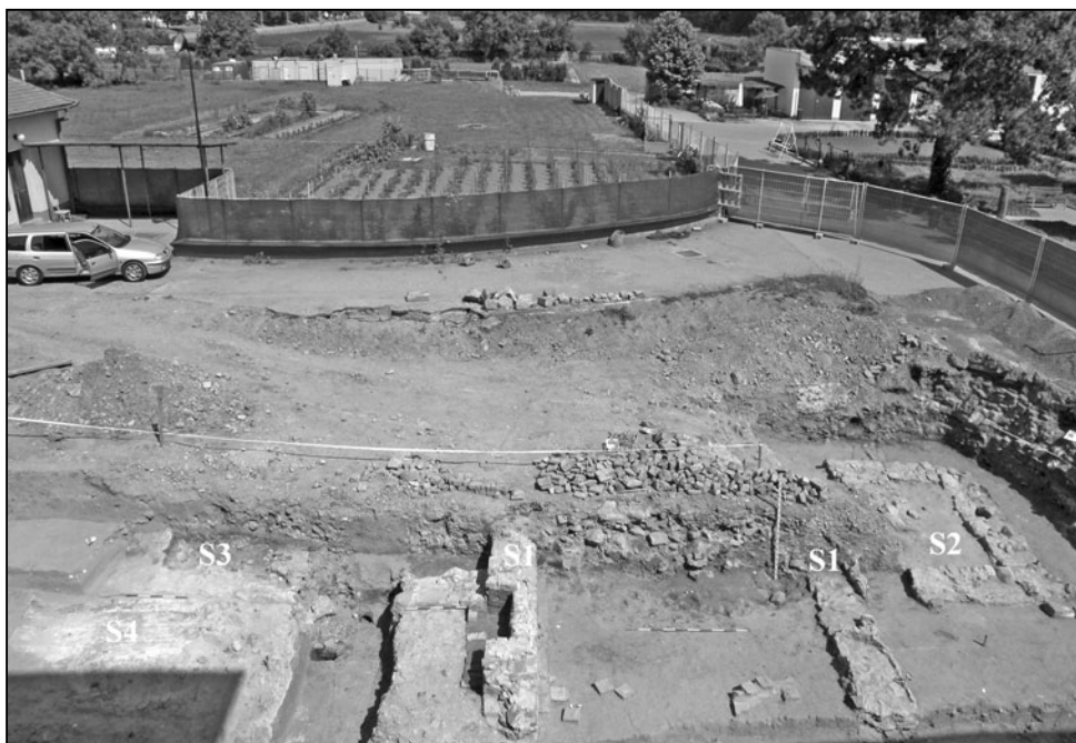
Obr. 9. Celkový pohled od západu z kaple Vincentina na plochu výzkumu před vstupem do lapidária a odkryté reliktu stavebních objektů (S2, S3) přizděných ze strany jižní a severní ke stavbě koridoru – S1, Velehrad 2011. Foto Z. Schenk.
