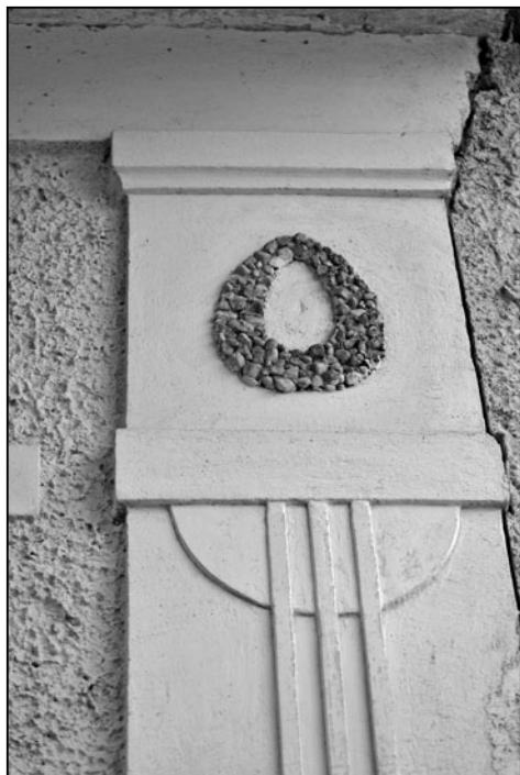
Detail štukové, empírové fasády usedlosti čp. 3, Troubky.
