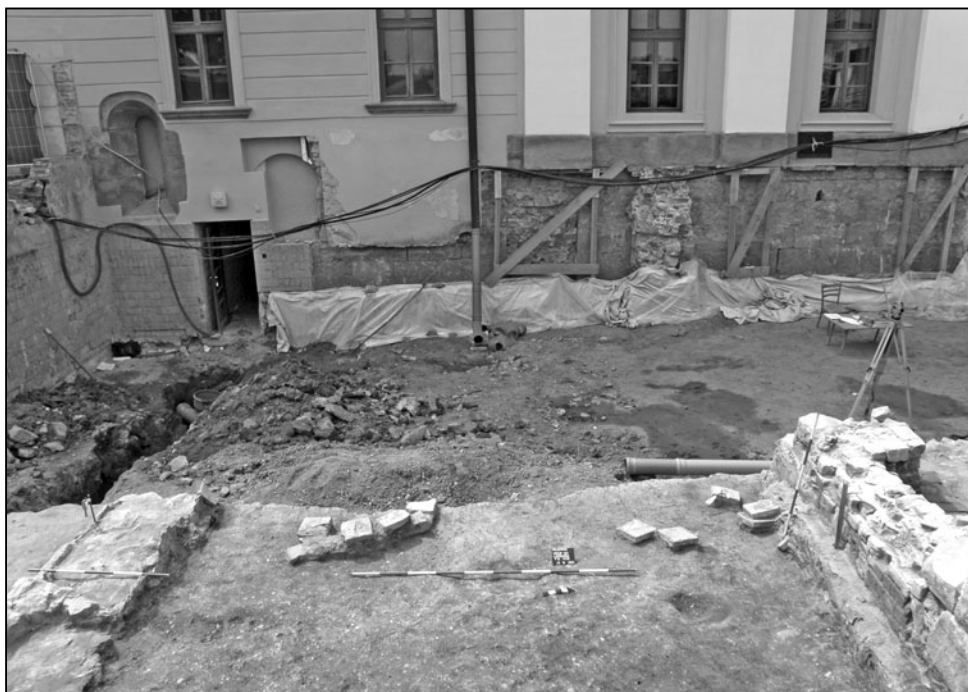
Obr. 10. Pohled od východu do středu koridoru (S1). V pozadí východní průčelí kvadratury se zazděným původním vstupem do parlatoria, Velehrad 2011. Foto Z. Schenk.
