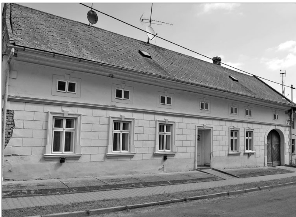
Usedlost čp. 66 s klasicistní fasádou s bosážováním, Troubky – náves.
