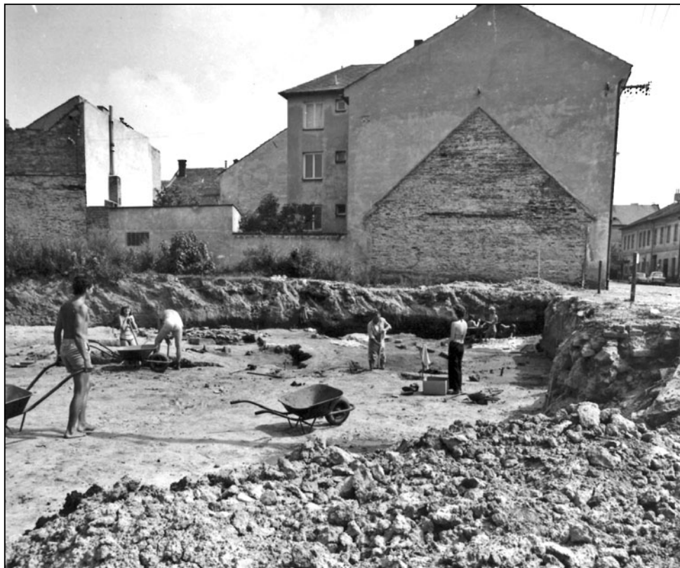
Obr. 4. Pohled na jižní polovinu zkoumané plochy (s objekty 2 a 7) na ulici Otakarově v roce 1979. Fotoarchiv Slovákckého muzea v Uherském Hradišti, autor L. Chvalkovský.
