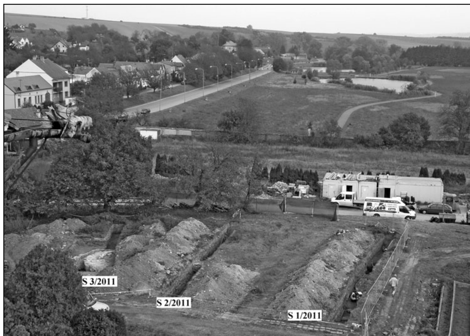
Obr. 17. Celkový pohled od západu na plochu zahrady Vincentina a polohu revizních sond S1-S3/2011. Na horizontu patrná rekonstruovaná stavba velkomoravského kostela v Modré, Velehrad 2011.
