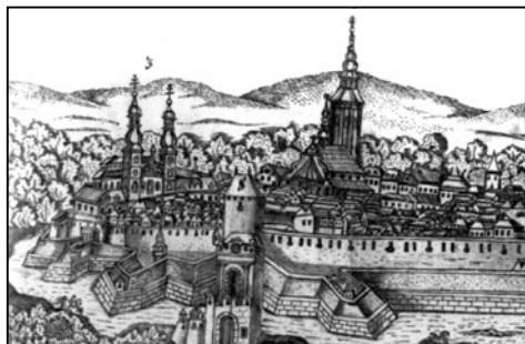
Obr. 3. Jezuitská kolej – po dokončení, K. A. Římař 1723–1728, převzato z http://gis.mesto-uh.cz/tms/shp_uh/index.php [citováno ze dne 24. 10. 2011].
