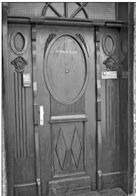
Detail empírově pojatých dveří usedlosti čp. 132, Roštín – náves.
