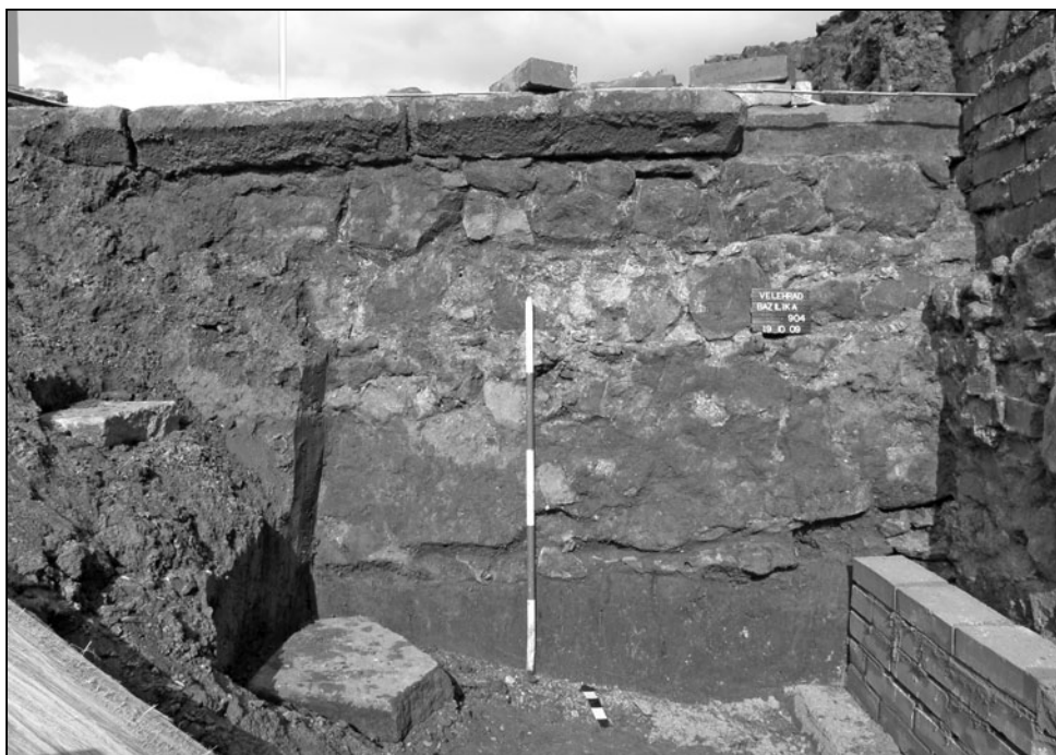
Obr. 3. Pohled od jihu na hydroizolační výkop před západním průčelím. V levém dolním rohu snímku je patrná nadzemní pískovcová patka v místě původního interiéru předsíně, Velehrad 2009. Foto Z. Schenk.
