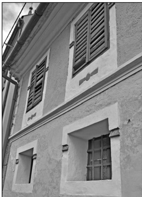
Detail oken s jemnou štukovou výzdobou dolní komory a sýpkového patra, které jsou kryté dřevěnými žaluziemi, usedlost čp. 33, Zdislavice.
