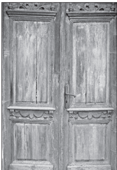
Hlavní vchodové dřevěné rámové dveře zdobené řezbářskými prvky.
