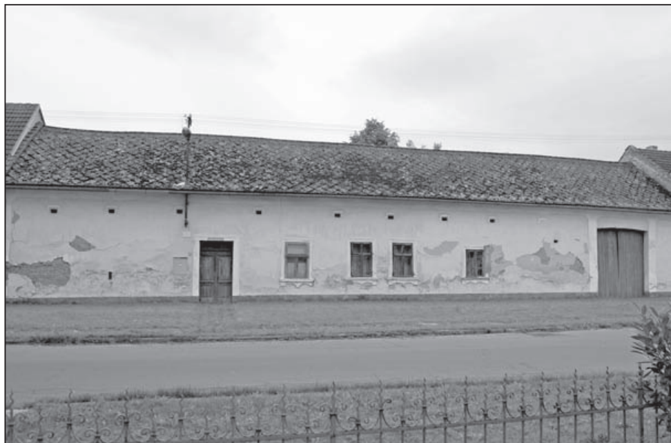
Široké okapové uliční průčelí usedlosti čp. 15.
