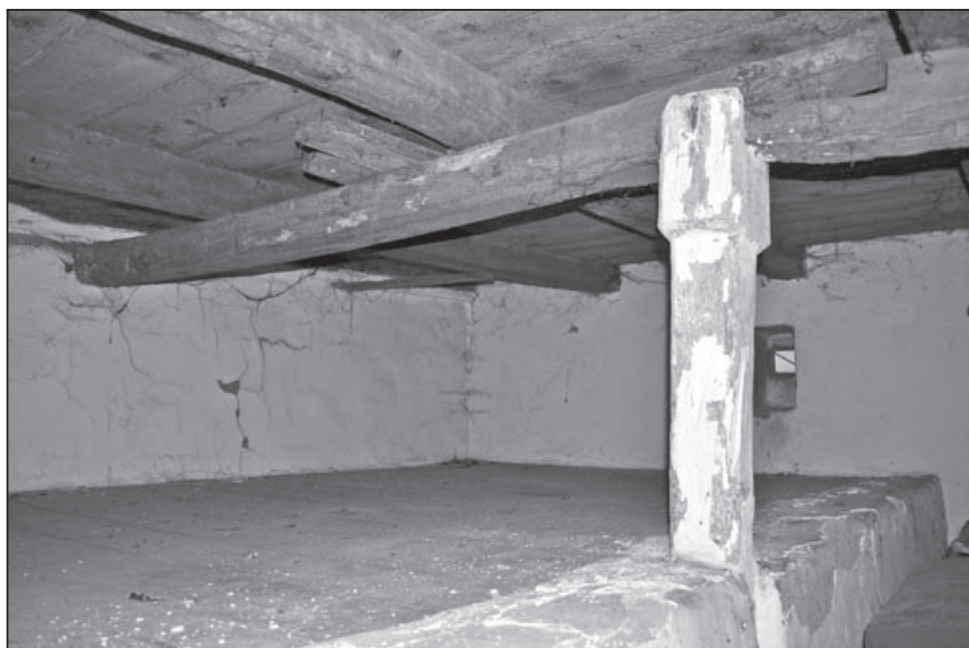
Patro komory s vyrovnáním stropu nad síní a podpěrným konstrukčním sloupkem.
