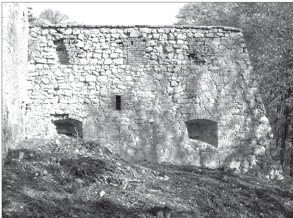
13. Hrad Buchlov; pohled na vnější fasádu krátkého úseku jižní části hradby (obr. 1/10).
