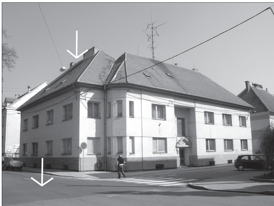
13. Kollárova ulice, celkový pohled na upravovaný a zkoumaný bytový dům od jihu. Šipka vlevo ukazuje místo nálezů zdiva bastionu sv. Josefa z roku 2007, šipka nahoře místo nálezů bastionu v suterénních prostorech tohoto objektu v roce 2009. Foto D. Menoušková.
