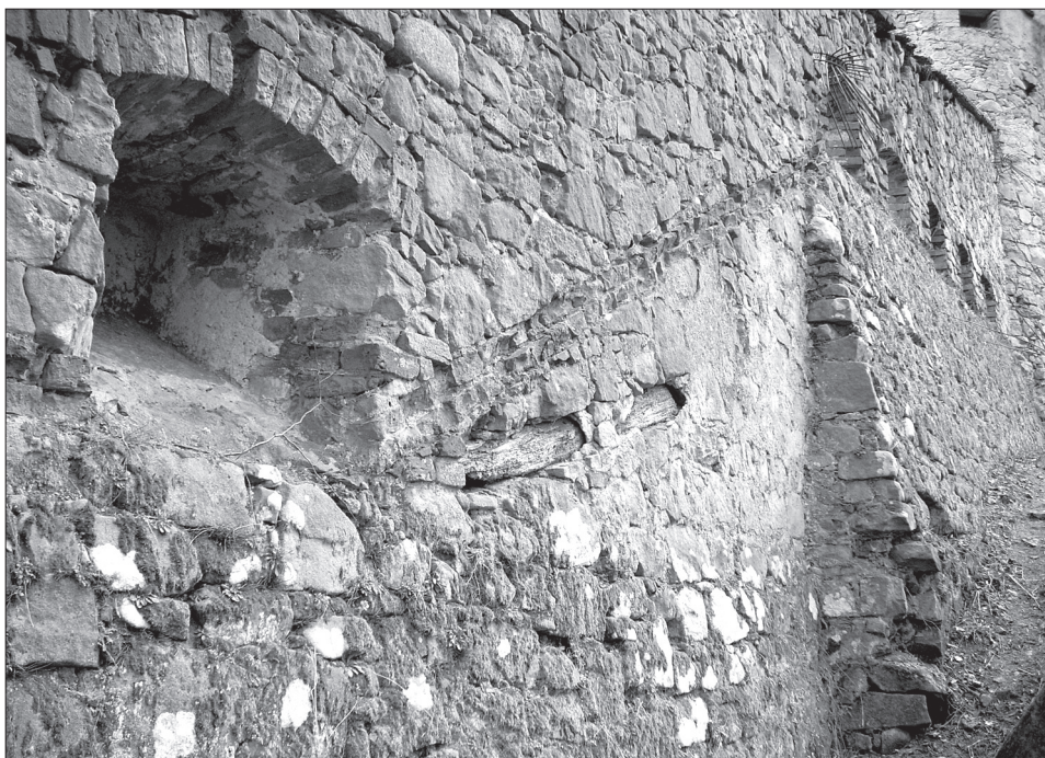
12. Hrad Buchlov; detail vnější fasády jižní hradby; vlevo zazděná střilna, napravo od ní stoupající úsek odsekané, cihlové římsy, pod ní zazděný trám, nacházející se zřejmě nad zrušenou vstupní šjí sklípku.
