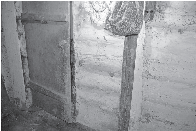
Detail roubení masivními kuláči v komoře usedlosti čp. 96, Študlov.
