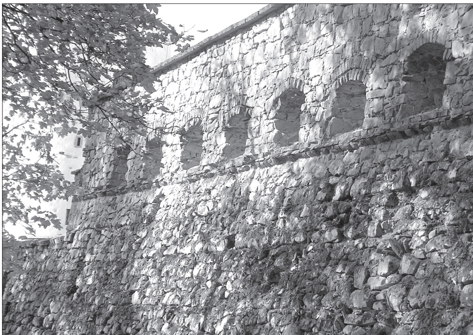
11. Hrad Buchlov; pohled na část vnějšího líce jižní hradby, navazující na bastion; na spodní, kónickou část nasedá cihelná římsa, nad ní řada střílen.
