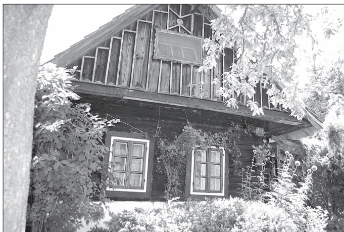
Provedení štítového prů- čelí pasekářské usedlosti čp. 103, Študlov.
