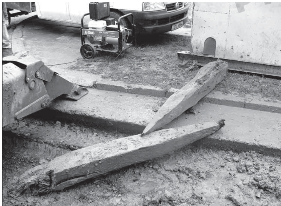
11. Uherské Hradiště, oprava kanalizační stoky „V“, třetí etapa 2007, křížení ul. Dlouhé a J. Lucemburského. Dubové kůly palisády příkopu, 2. pol. 15. století. Foto D. Menoušková.
