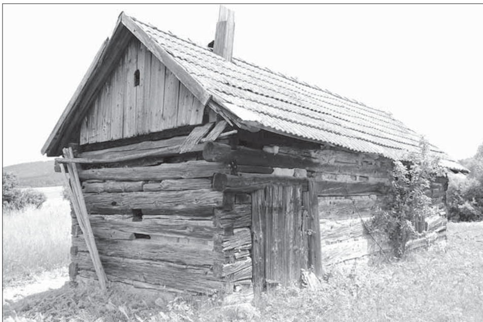
Vrbětice, extravilán obce – roubená sušárna na ovoce s dřevěným komínem na sedlové střeše.
