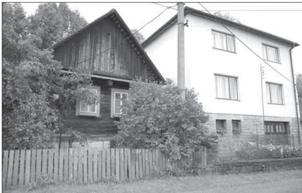
Nedašova Lhota, roubená usedlost čp. 27 v kontrastu se sousední novodobou stavbou.
