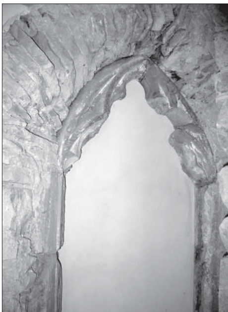
Detail gotického okna bílovického kostela. Foto Jiří Jilík, 2008.
