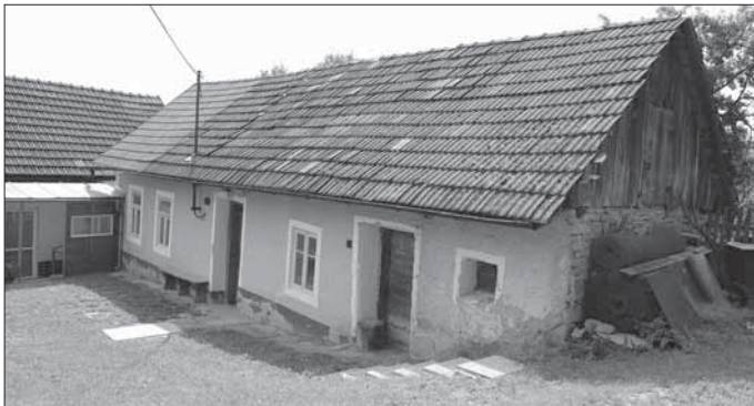
Popov, podélně orientované stavení čp. 50.
