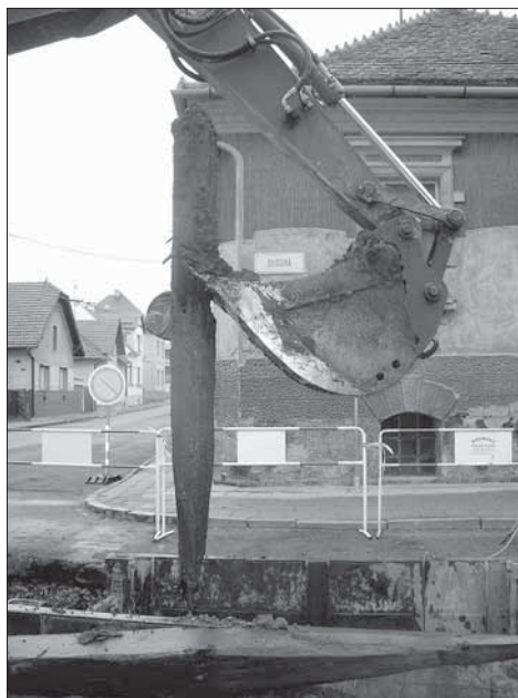
12. Uherské Hradiště, oprava kanalizační stoky „V“, třetí etapa 2008, ul. Dlouhá. Vyzdvížení dalších rozměrných dubových kůlů palisády bagrem, 2. pol. 15. století, západní profil. Foto D. Menoušková.
