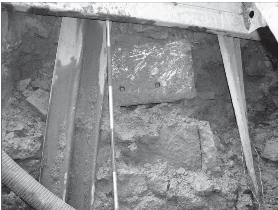
9. Uherské Hradiště, oprava kanalizační stoky „V“, druhá etapa 2007, ul. U Reduty, druhotně užitě ostění renezančního okna s otvory pro mříže ve vnější hradební zdi, severovýchodní profil. Foto D. Menoušková.
