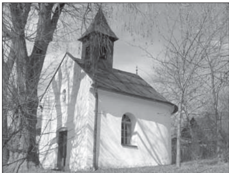
obec: Košíky název a zasvěcení: kaple Panny Marie bližší umístění: na horním konci obce datace: 1888 rozměry: 500×500 cm (bez závěru)
