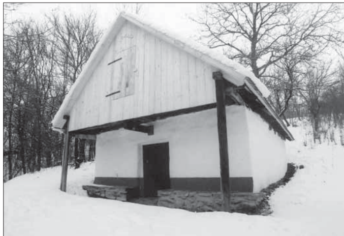
Vinohradnická stavba tzv. „búda.“
