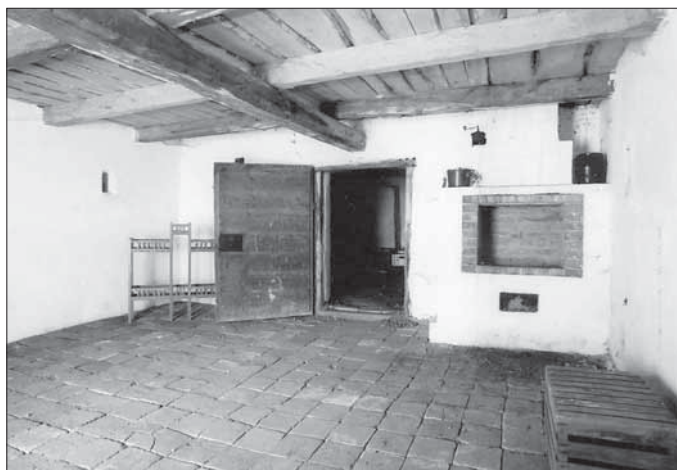
Rozlehlá lisovna po obnově stropu a podlah slouží ke společenským setkáním nebo k ukládání ovoce.
