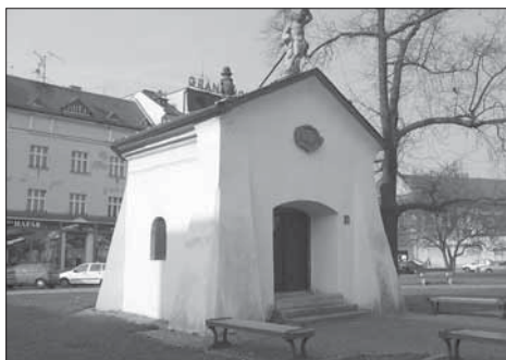
obec: Uherské Hradiště název a zasvěcení: kaple sv. Šebestiána bližší umístění: Palackého náměstí datace: 1715 rozměry: 285×270; 90×90 cm (nárožní bastiony)
