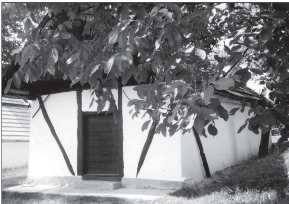
4. Vinná buda se znaky jednoduchého hrázdění natřené nevhodně černou barvou. Vlčnov.
