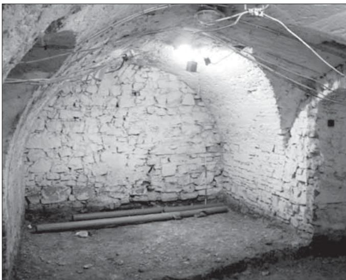
22. Barokní sklepy pod severovýchodním traktem zlínského zámku. Foto R.Vrla.
