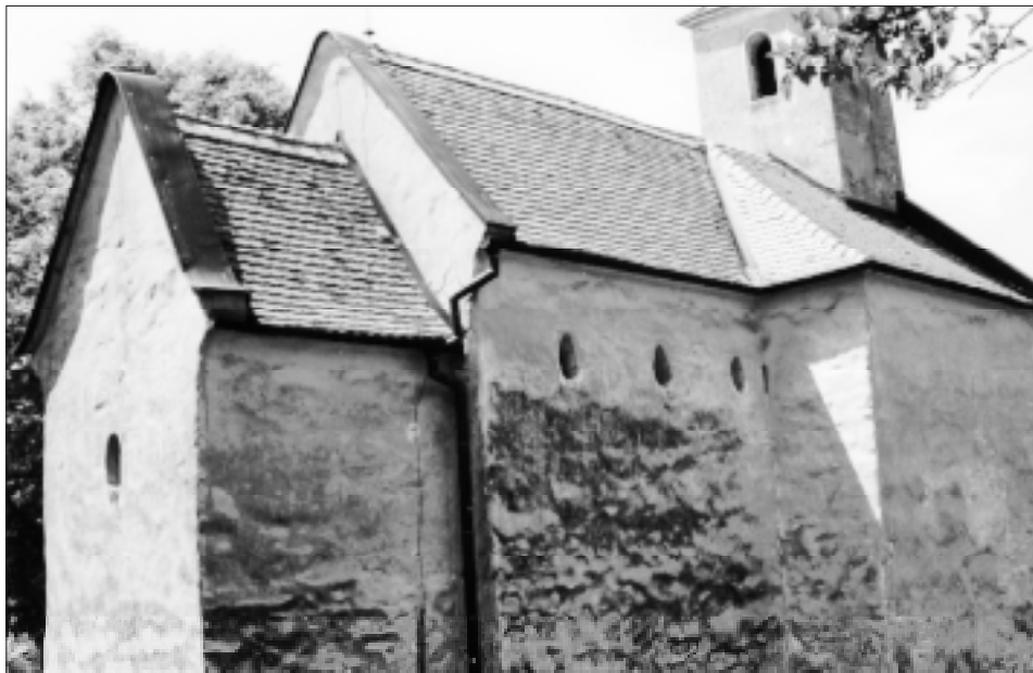
Obr. 5. Kostolík sv. Juraja v Kostolnoch pod Tribečom. Pohľad zo severovýchodu.
