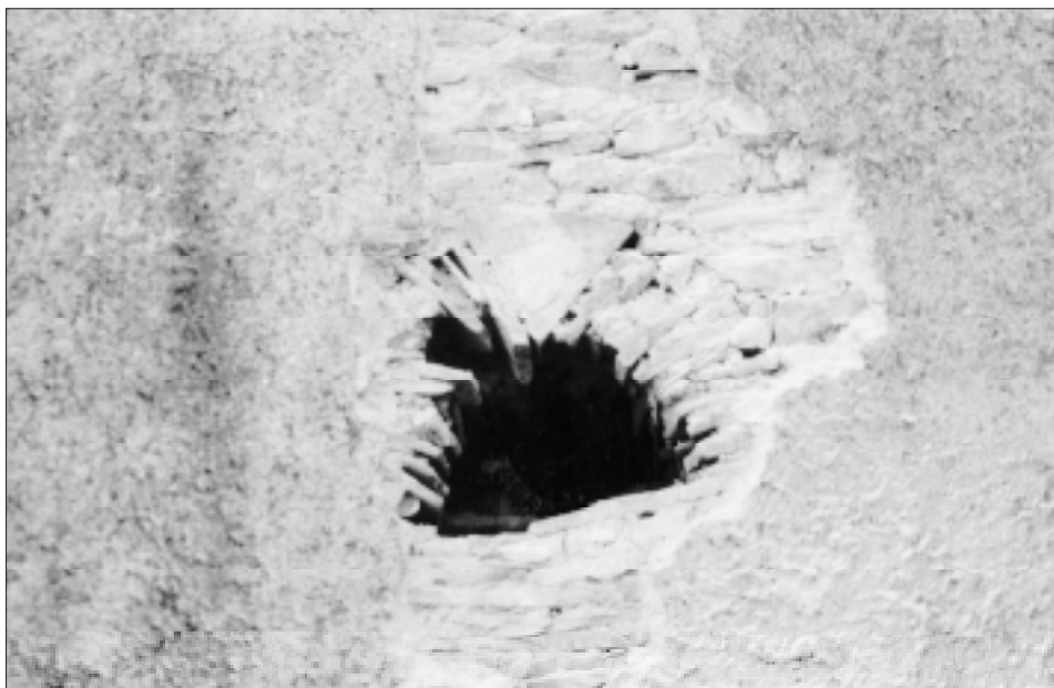
Obr. 2. Kaplnka sv. Margity pri Kopčanoch. Východné okno severnej steny lode kaplnky.
